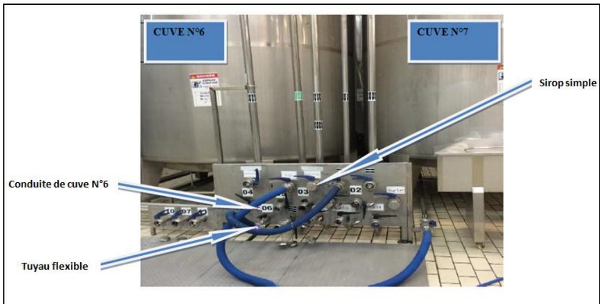
Figure I.7 : Transfert du sirop simple vers la cuve N°6 sur la plaque multivoie N°1
