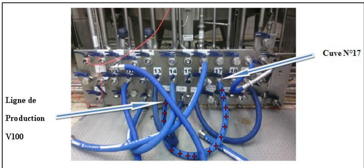
Figure I.8 : Transfert du sirop fini vers une ligne de production sur la plaque multivoies N°2.
