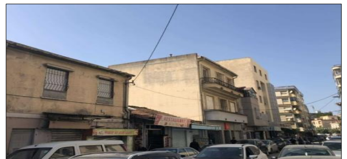
Figure 78: La vue sur la façade droite de la rue Oubouzar Cherif. Source : Auteur 2024
