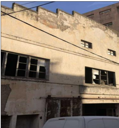
Figure 79: La friche (avant). Source: auteur
