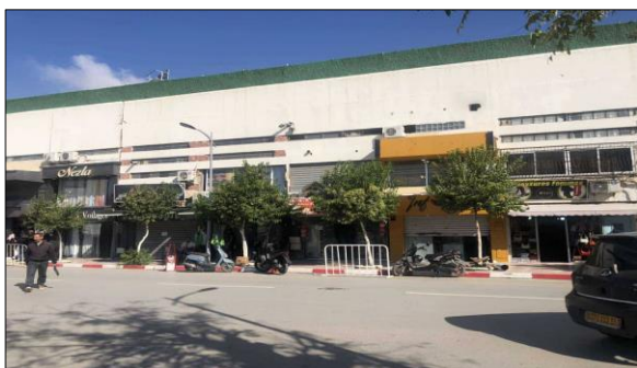
Figure 83: La façade du stade (avant). Source: auteur
