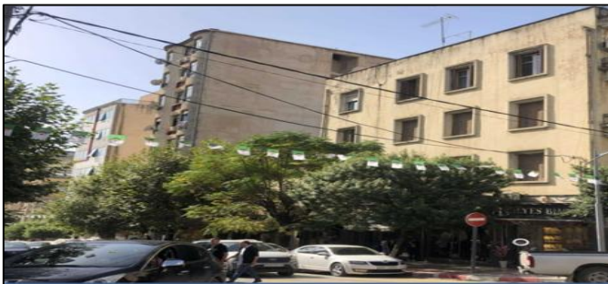
Figure 62: La vue sur la façade gauche du Bd Md Said Ouzeffoun. Source: Auteur 2024
