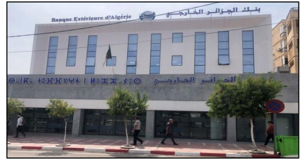
Figure 152: Vue sur la façade principale de la BEA. Source : auteur 2024
