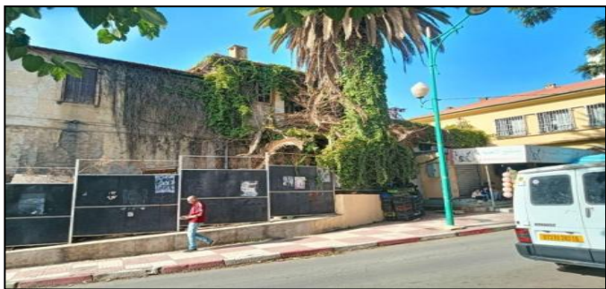
Figure 97: La vue sur la façade gauche de la rue Souibes Rabah. Source: Auteur 2024
