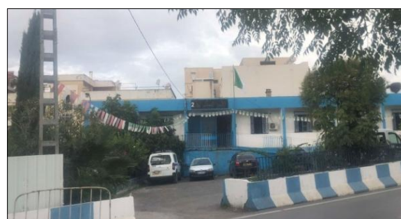
Figure 150: Vue sur la façade principale du commissariat. Source : auteur 2024
