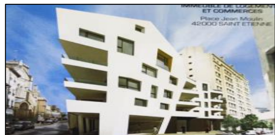
Figure 53: Habitat collectif (après). Source : Habiter aujourd'hui à saint Etienne
