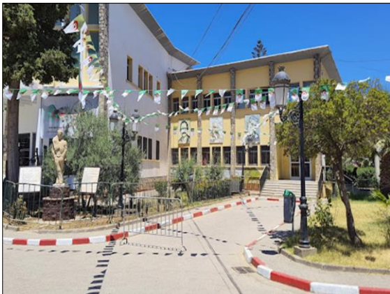
Figure 66: La maison de la culture (avant). Source: auteur
