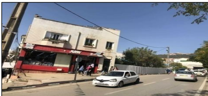
Figure 72: La vue sur la façade gauche de la rue Rabia Ali. Source : Auteur 2024
