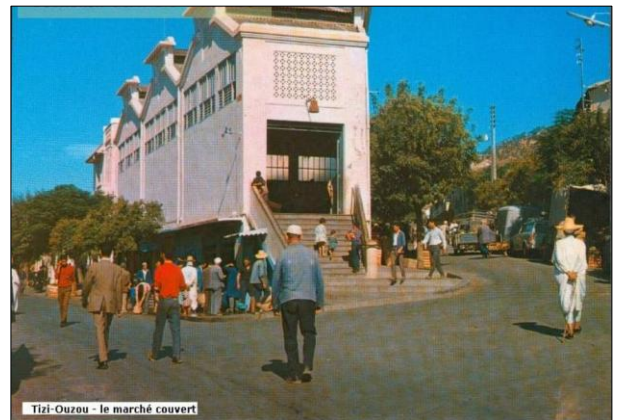
Figure 40 : L'ancien marché couvert de la ville de Tizi Ouzou. Source : Tizi ousou Voirie تيزي وزو
