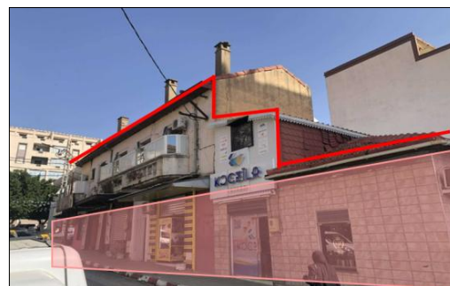
Figure 169: Vue sur la façade de la rue de la paix. Source : auteur 2024
