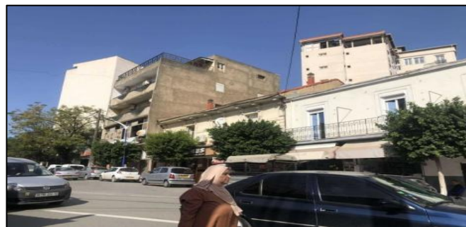
Figure 103: La vue sur la façade droite de la rue Mazira Mohamed Arezki. Source : Auteur 2024
