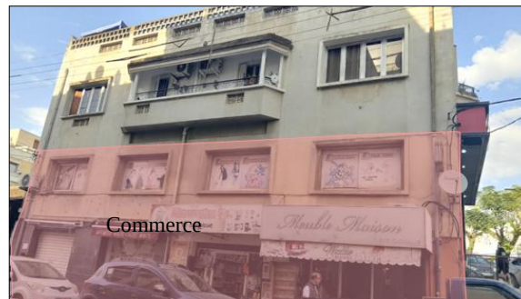
Figure 160: Vue sur la façade principale de l'habitat individuel. Source : auteur 2024
