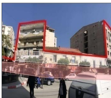
Figure 131: Vue sur la façade de la rue Mazira. Source : auteur 2024
