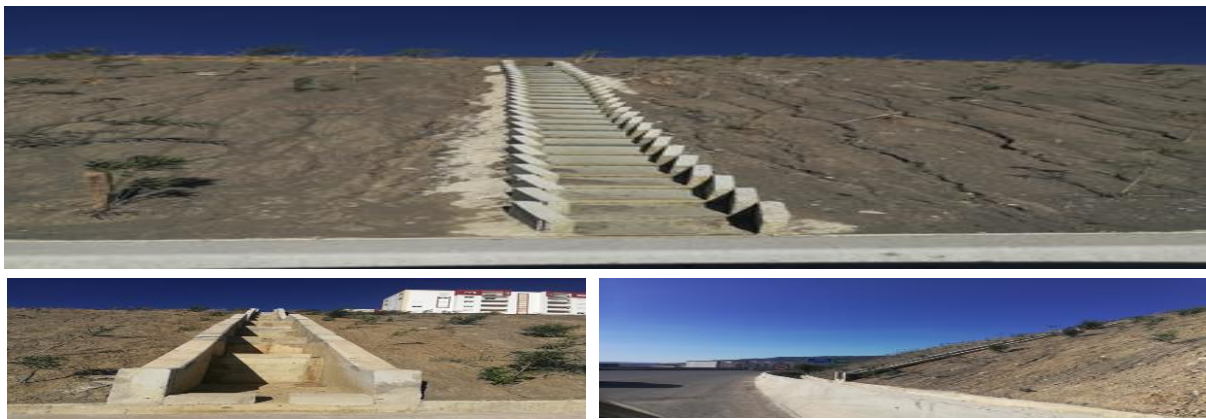
Figure n°4.18: Système de drainage au niveau du mur PK 1+04.
