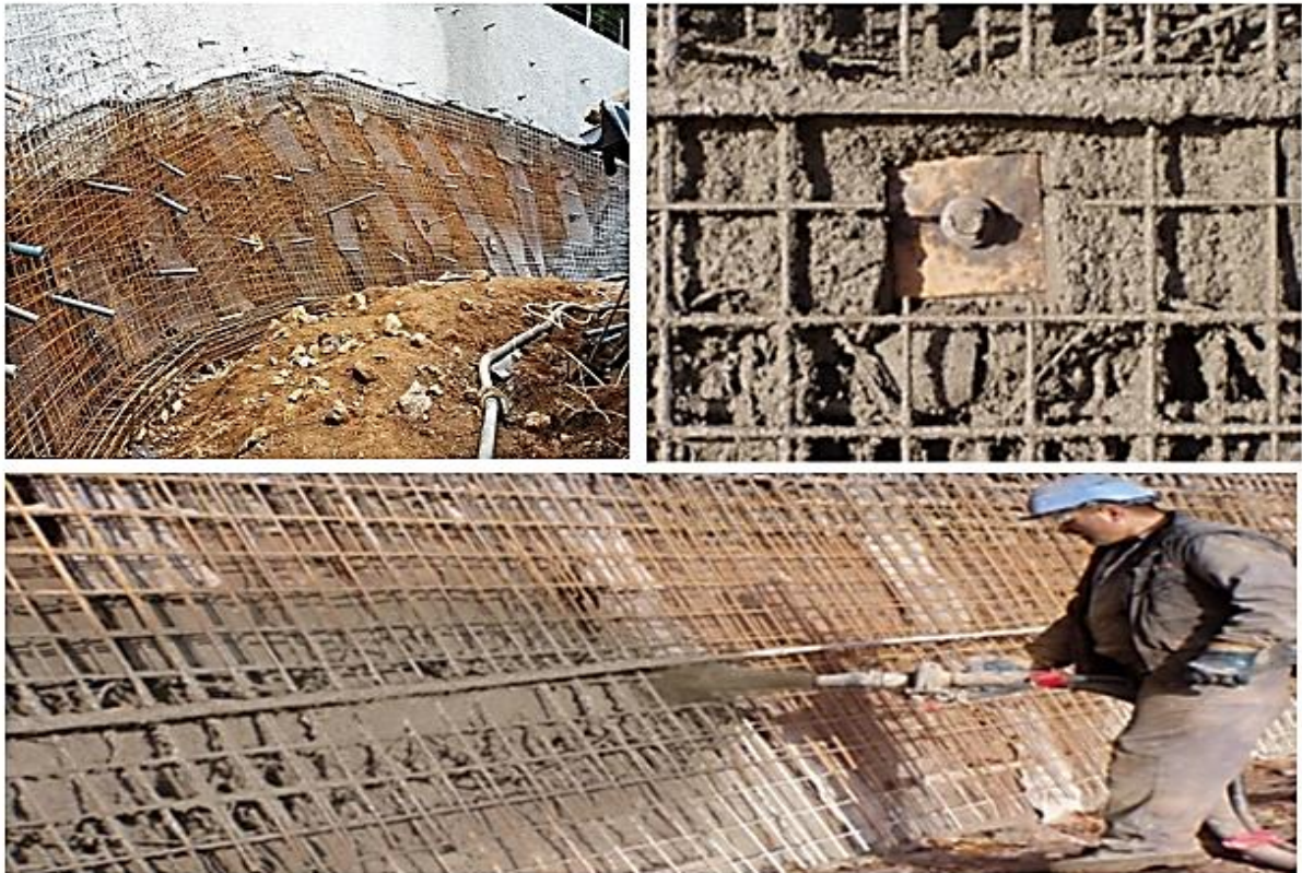
Figure n°4.70: Exemple de stabilisation de talus par clouage.
