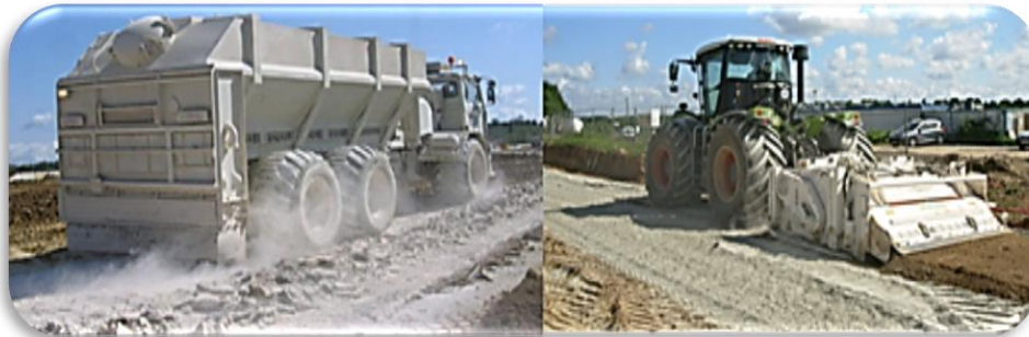
Figure n°1.41 : Traitements du sol avec la chaux et ciment www.atlas.nrcan .
