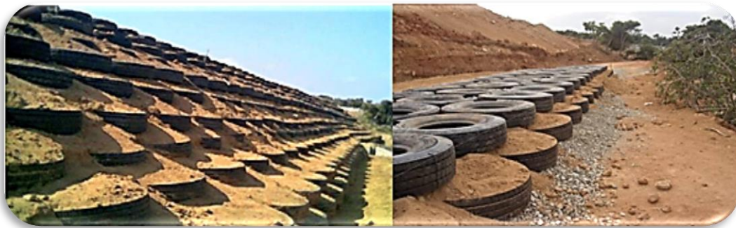
Figure n°1.33 : Renforcement d'un talus avec la technique pneu sol à la ville de BOUSMAIL (2005) (Algérie).
