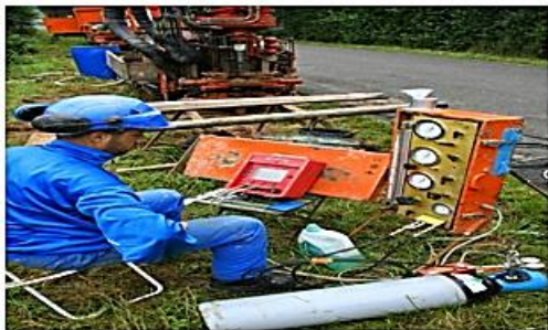
L'appareil préssiométrique au cours réalisation
