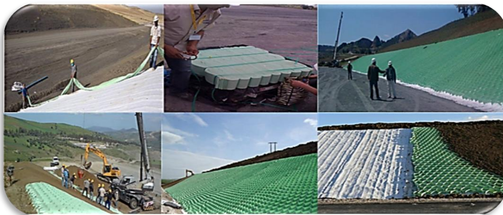
Figure n°1.32 : Le renforcement d'un massif par géosynthétiques sur l'Autoroute Est-Ouest 2009/2010 (Algérie).
