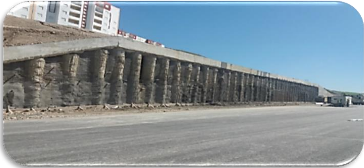
Figure n°4.52: Vue du mur PK 1+040 après réalisation.
