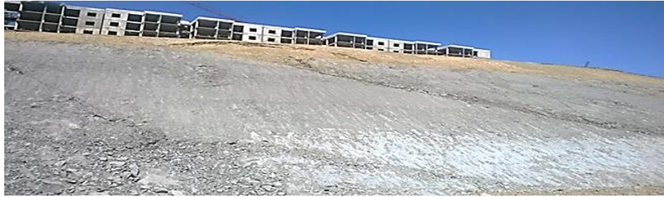
Figure n° 3.13: Excavation du talus au p.k. 1+060 à l'hiver.
