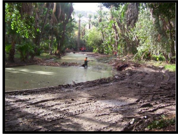
Figure 45 : Photo 1 : Photo des travaux de restauration du jardin anglais, jardin d'Essai du Hamma, Alger
