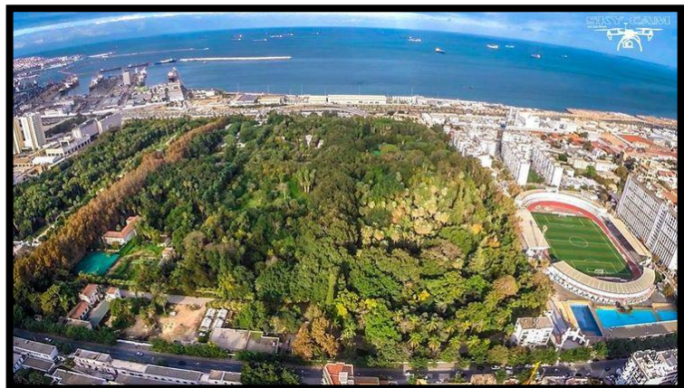
Figure 68 : photo aérienne du jardin d'essai
