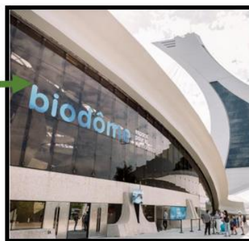
Figure 36 : façade principale du biodôme.
