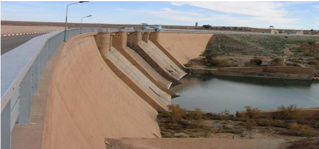
Figure I.7 : Barrage poids de Djorf Torba wilaya de Béchar (wikipedia.org)
