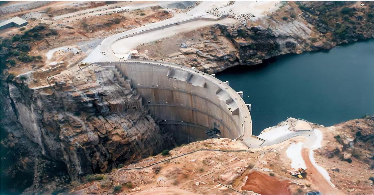
Figure I.9 : Photo d'un barrage-voûte (encyclopedie-energie.org).
