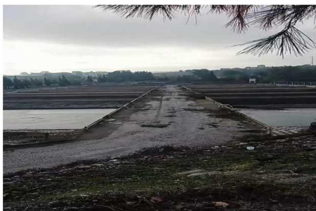
Figure 15 : lits de séchage (Mouas et Mazouni, 2024).
