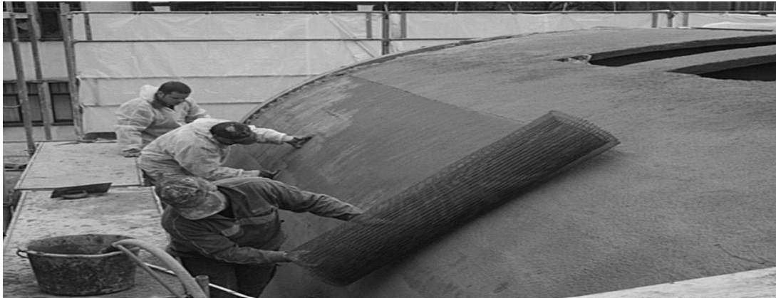
Figure II.12 : Rénovation d'un toit en forme de tonneau à Zwickau en Allemagne [24].
