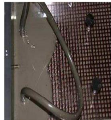
c) Injection du mortier
