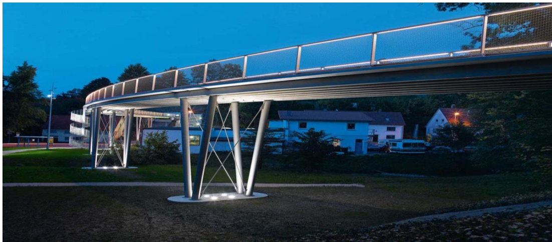
Figure II.13 : Passerelle piétons de Lautlingen en Allemagne [24].
