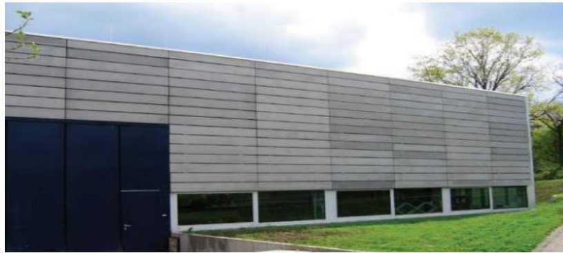
Figure II.14 : Institut-fritz en Allemagne [21].
