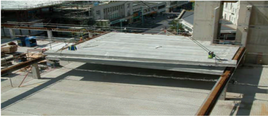
Figure 3.5 : Eléments préfabriqués en béton placés sur des poutres non mixte.
