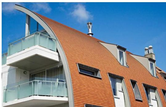
Figure 204 : toiture et façade en terre cuite
