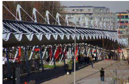
Figure 20 :La galerie de la villette. Source : https://lh4.googleusercontent.com/
