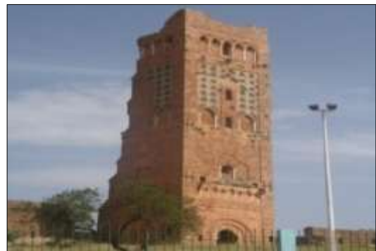
Figure 6 : Le minaret des rampants de Mansourah Source : prise par l'auteur
