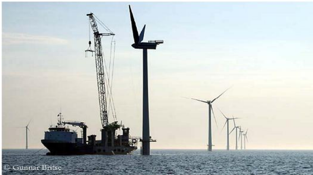
Figure1-2.Installation d'éolienne offshore en mer de nord (photo GUNNAR BRITSE)
