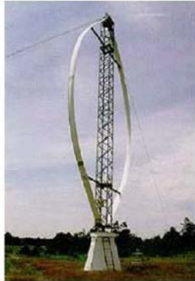
Figure1-5. Eolienne de Darrieus.
