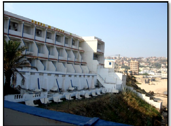
Figure 62 : hôtel El Manar. Source : https://www.google.com/img .
