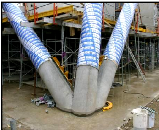
Figure 143 : poteaux inclinés en béton.
