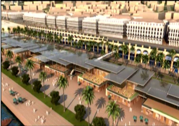
Figure16: réhabilitation de front de mer. Source : stratégie urbaine 2030, (vidéo).
