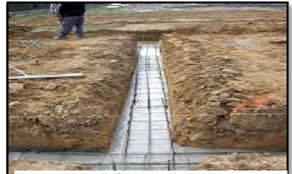
Figure 131 : semelle filante sur chantier. Source : https://www.google.com/imghp .
