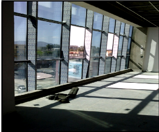
Figure 148 : façade rideau d'un immeuble. Source : les auteurs.
