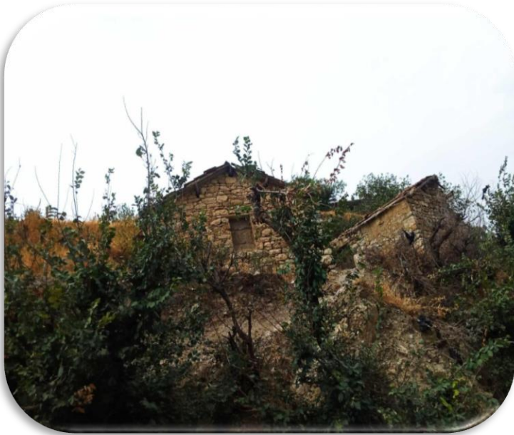
Photo N° 10 : Ancienne maison de Bouthaldja Ahmed détruite par le bombardement de l'armée coloniale
