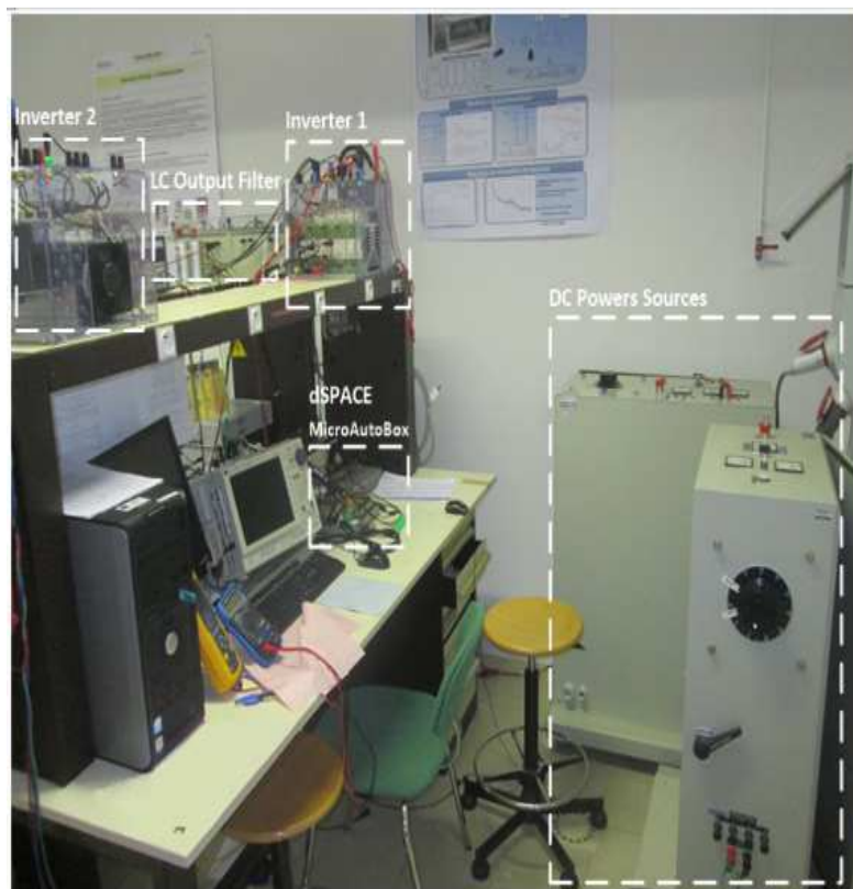
Figure 3.17 Banc de test expérimental du micro-réseau autonome
