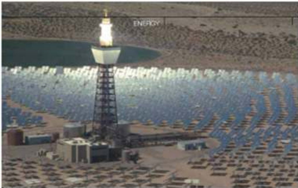
Figure II.9 : centrale solaire à tour (Californie) [26]
