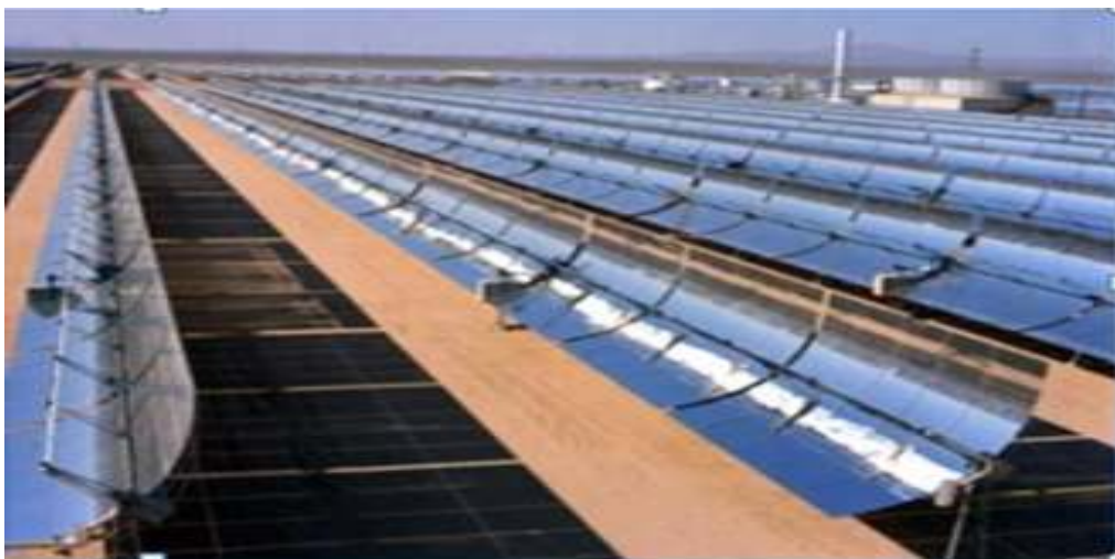
Figure II.3 : Centrale solaire à miroirs cylindro-parabolique [20]
