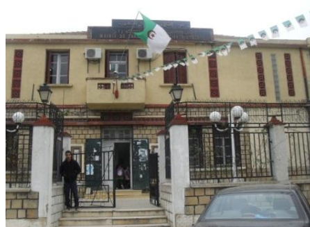
Figure 47: siège de l'APC, source : l'auteur
