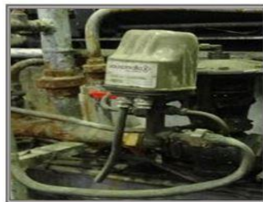
Figure III.13 : Electrovanne circuit de refroidissement.
