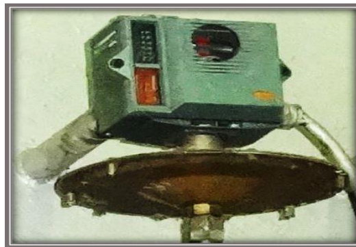
Figure III.7 : Pressostat de l'air et du gaz naturel.
