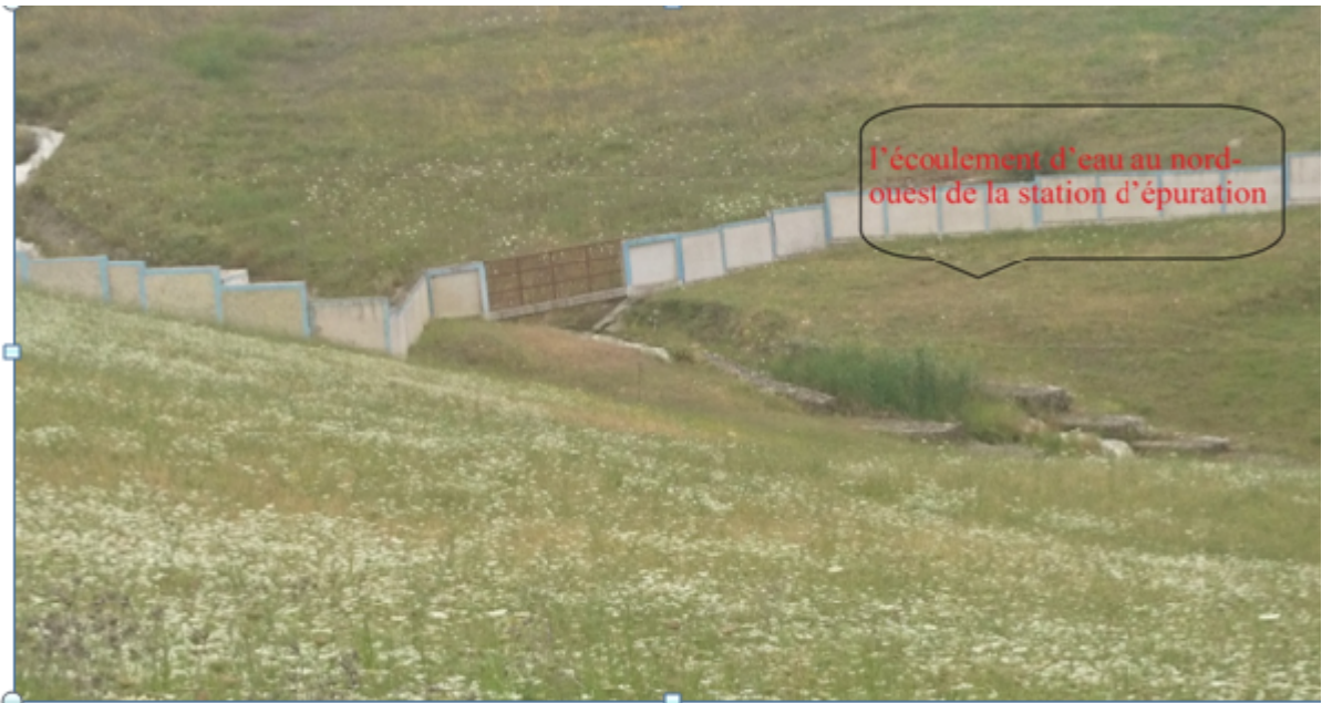
Le passage sous l'écoulement d'eau
