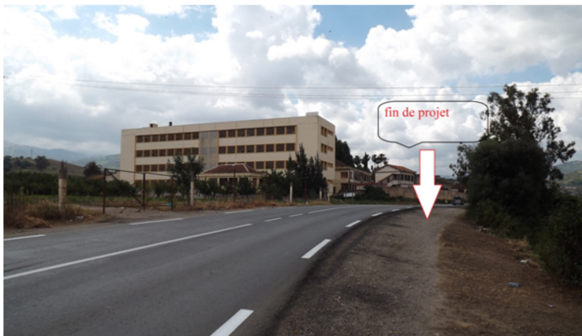
Zone de raccordement de la variante 2 avec la RN15 après l'oued de TAKSEBT
