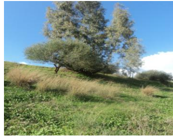
Photo 4.50 : Végétation arbustive sur le talus aval.
