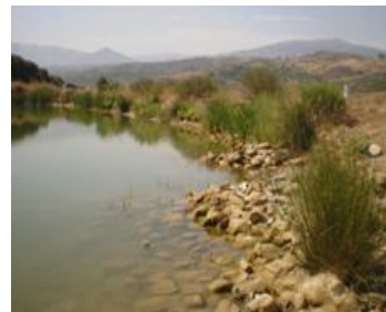
Photo 2.9 : Désordre d'où au battillage.
