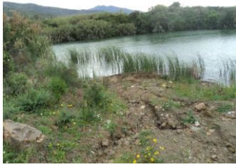
Photo 4.155 : Creusement de ravines en bordure de la retenue
