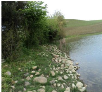
Photo 4.106: Glissement des enrochements de talus amont de la digue
