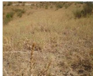
Photo 4.8 : présence de ravines sur le parement aval.
