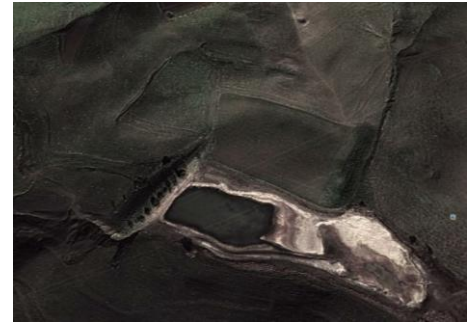
Photo 4.108. Vue générale de la retenue Mekla 368.
