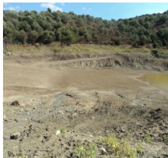
Photo 4.13 : Envasement partiel de la retenue.
