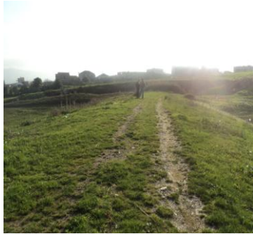
Photo 4.56 : Ornières sur la crête.
