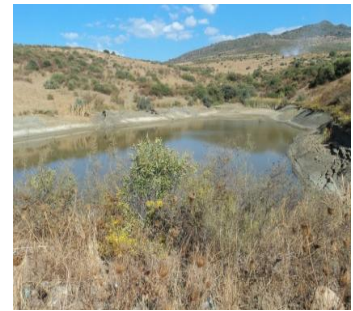
Photo 4.4 : Présence de végétation sur le talus amant.
