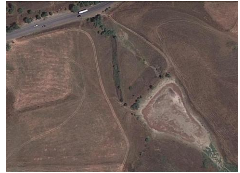
Photo 4.127. Vue générale de la retenue Mekla 394.
