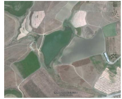
Photo 4.81. Vue générale de la retenue Freha 396.
