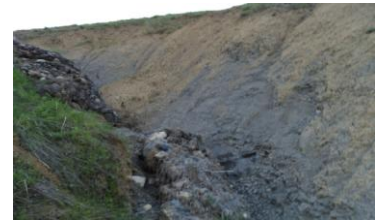
Photo 4.120 : Destruction de l'évacuateur de crue
