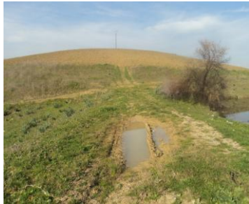
Photo 4.85 : Orniérage sur la crête
