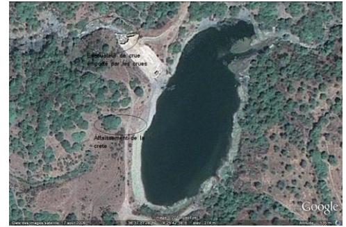
Photo 4.10. Vue générale de la retenue Bouzguene N°3.
