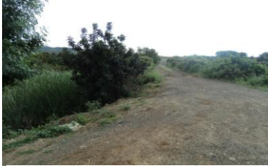
Photo 4.148 : Végétation arbustive sur le talus amont
