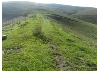
Photo 4.31 : Affaissement de la crête retenue.
