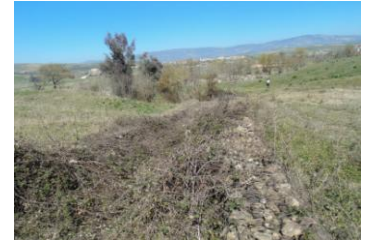
Photo 4.133 : Colmatage de l'évacuateur de crue
