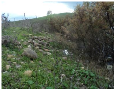
Photo 4.62: Végétation arbustive sur le talus amont.
