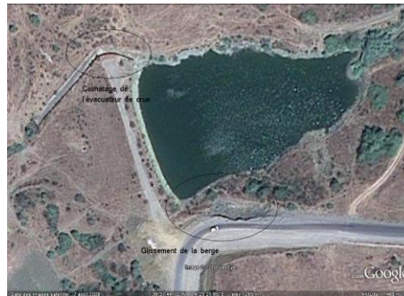
Photo 2.1 : Vue générale de la retenue Bouzeguene N°2.
