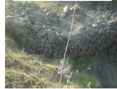
Photo 4.46 : Creusement de ravines sur le parement aval.
