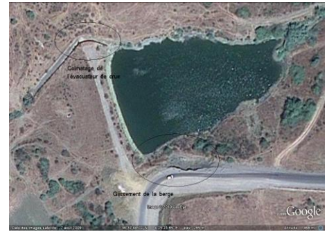
Photo 4.1 : Vue générale de la retenue Bouzeguene N°2.
