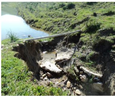
Photo 4.125 : Destruction de l'évacuateur de crue
