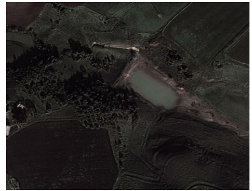
Photo 4.115. Vue générale de la retenue Mekla 391 .
