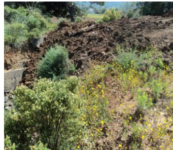
Photo 4.171 : Obturation de l'évacuateur des crues par les remblais Et la végétation
