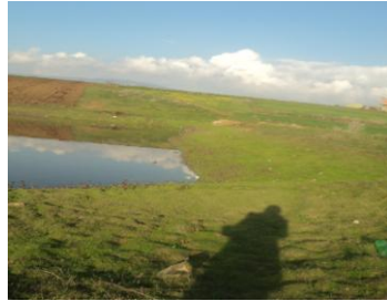
Photo 4.57 : Talus amont non protégé.
