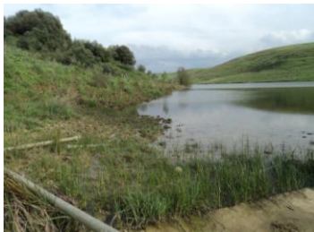
Photo 4.112 : Végétation arbustive sur le talus amont
