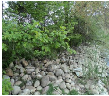
Photo 4.106: Glissement des enrochements de talus amont de la digue
