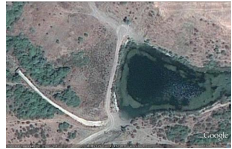
Photo 4.22. Vue générale de la retenue Illoula oumalou N° 1
