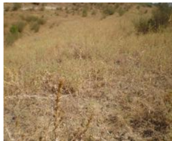
Photo 2.8 : Creusement de ravin sur le parement aval.
