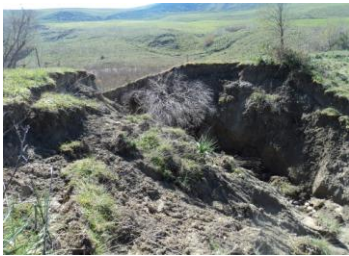
Photo 4.131 : glissement du talus amont.
