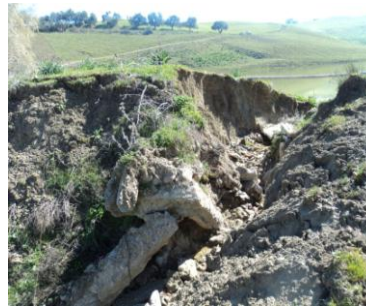
Photo 4.125 : Destruction de l'évacuateur de crue
