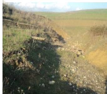
Photos 4.47. Evacuateur de crue endommagé.
