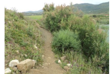
Photo 4.160 : Orniérage au pied du talus amont de la retenue
