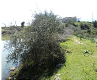
Photo 4.92 : Végétation arbustive sur le talus amont de retenues
