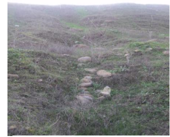
Photo 4.46 : Creusement de ravines sur le parement aval.
