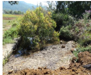
Photo 4.171 : Obturation de l'évacuateur des crues par les remblais Et la végétation
