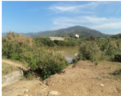
Photo 4.165 : Evacuateur de crue Obturé
