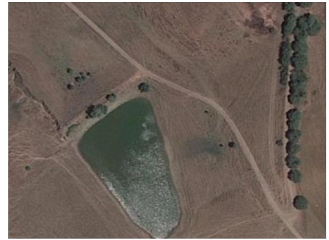
Photo 4.121. Vue générale de la retenue Mekla 393.
