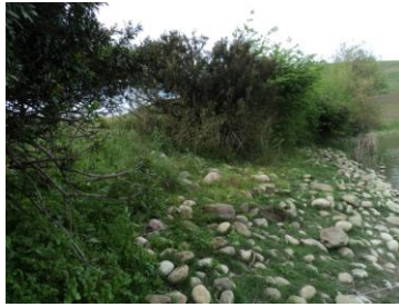
Photo 4.103 : Végétation arbustive sur le talus amont
