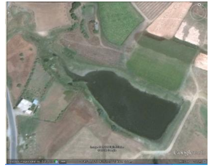
Photo 4.55. Vue générale de la retenue Timizart 388.
