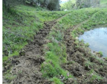
Photo 4.110 : Dégradation de talus amant par le passage des véhicules
