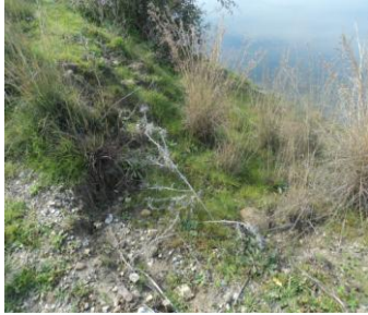
Photo 4.40: Creusement de ravines sur le narement aval.
