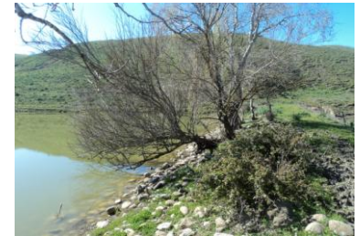
Photo 4.124 : Végétations arbustives sur le talus amont
