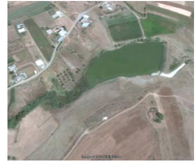
Photo 4.61. Vue générale de la retenue Timizart
