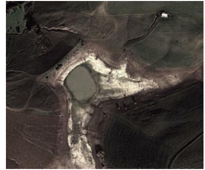
Photo 4.102. Vue générale de la retenue Mekla 367.
