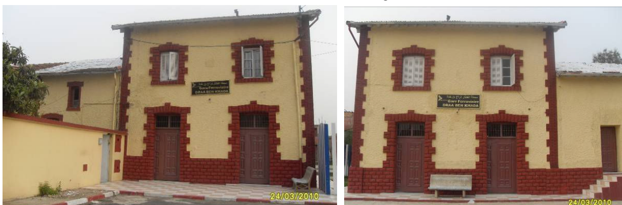
Figure 162 : Gare de Draa Ben Khedda. Etat relativement bon du bâtiment voyageur (rénové). Les façades côté cours (à gauche) et côté rails (à droite). [Source : Photo personnelle]
