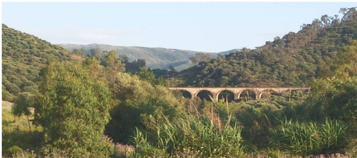
Figure 167 : Viaduc sur l'oued chender à Naciria [Source : Photo anonyme]
