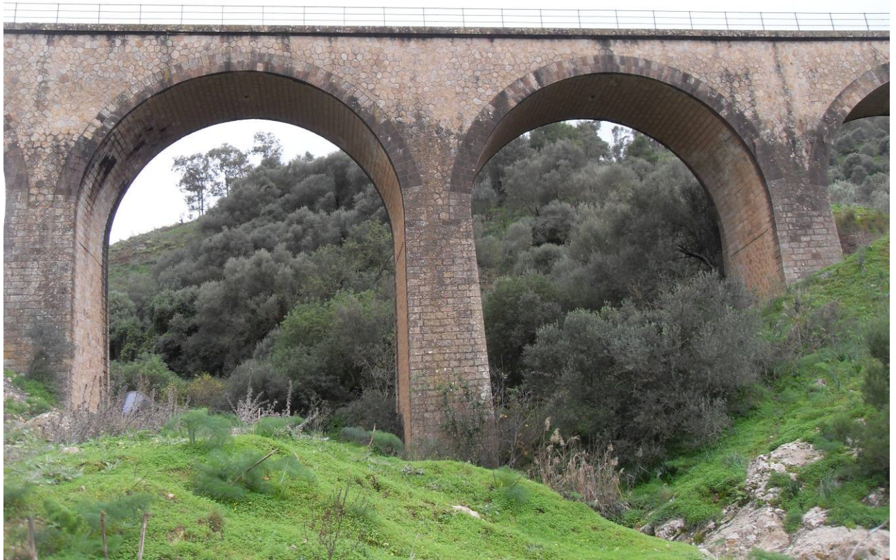
Figure 172 : Viaduc ferroviaire sur oued chender à Naciria, vue partielle. Détail des arches et les différents appareils de la maçonnerie. [Source : Photo personnelle]
