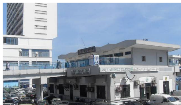
Figure 101 : Actuelle gare Agha à Alger. B.V dont le RDC sert de siège de banque [Source: Photo personnelle]
