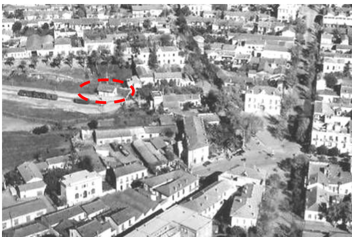
Figure 164 : Gare voyageur au centre-ville de Tizi Ouzou, aujourd'hui disparue. [Source : © Collection Marcel Lagarde]
