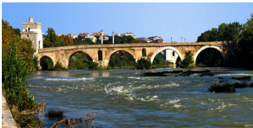
Figure 55 : Le pont Milvius à Rome, en maçonnerie de pierre.
