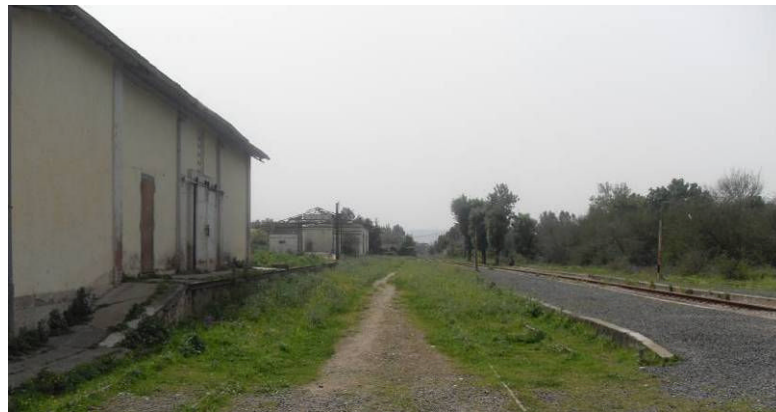
Figures 156 : Gare de Bordj Ménail, vue intérieure. [Source : Photo personnelle]
