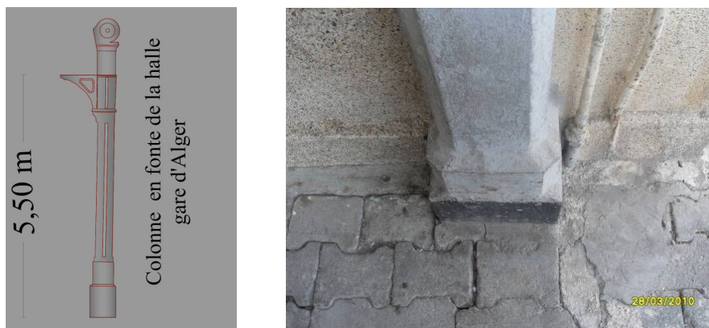
Figure 129 : Colonne en fonte de la halle-gare d'Alger. [Source : Illustration et photo personnelle]
