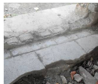
Figure 145 : Vue dallage du sol d'origine
