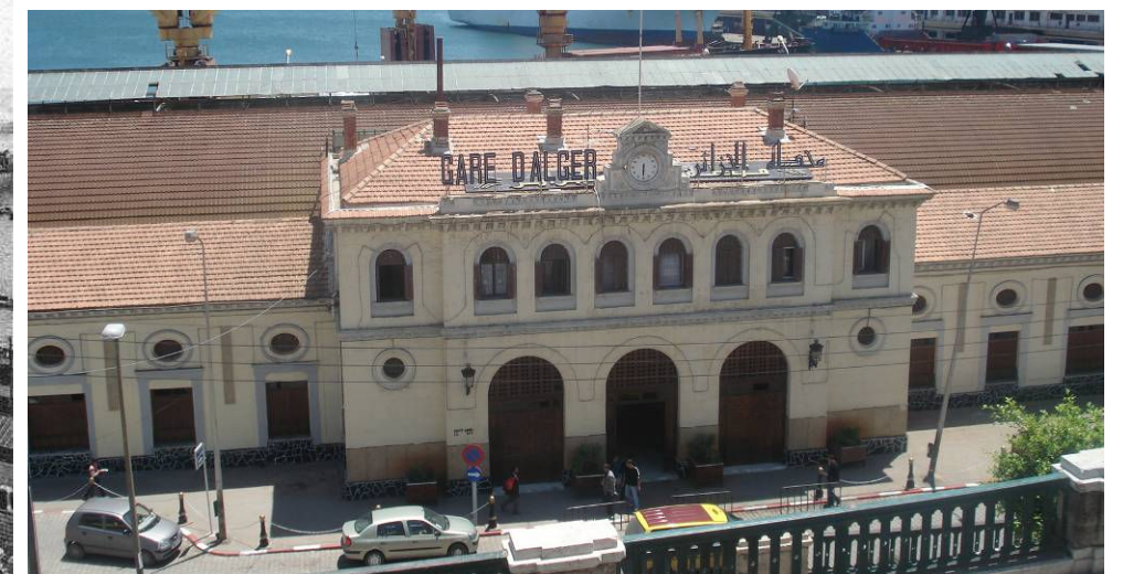
Figure 117 : Le bâtiment voyageur de la gare d'Alger. Le pavillon central (entrée) en saillie et les ailes latérales.
