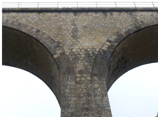
Figure 170 : Détail appareillage [Source : Photo personnelle]
