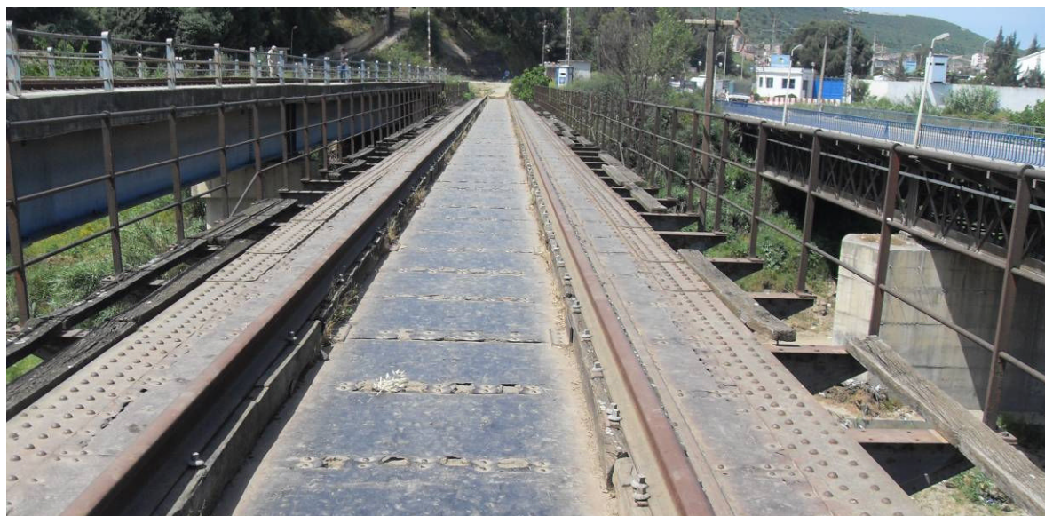
Figure 188 : Le plancher du pont, le trottoir et les consoles. [Source : Photo personnelle]
