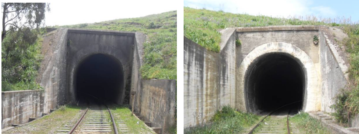
Figure 202 : Les têtes d'ouvrage, coté Thénia (à gauche) et côté Tizi Ouzou (à droite).
