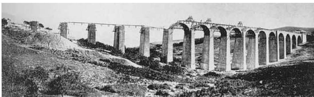
Figure 178 : Réalisation du viaduc, à 15 arches de 12 m d'ouverture, des chénachas à Tadmaït. Exécution des voûtes sur cintre. [Source : P. Bejui et al., op. cit., p. 17]
