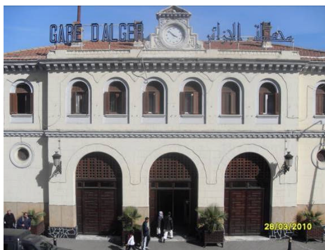
Figure 122 : Façade classique de l'entrée, arcs en plein cintre pour les ouvertures. [Source : Photo personnelle]
