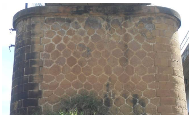
Figure 184 : Détails de maçonnerie d'une pile. [Source : Photo personnelle]
