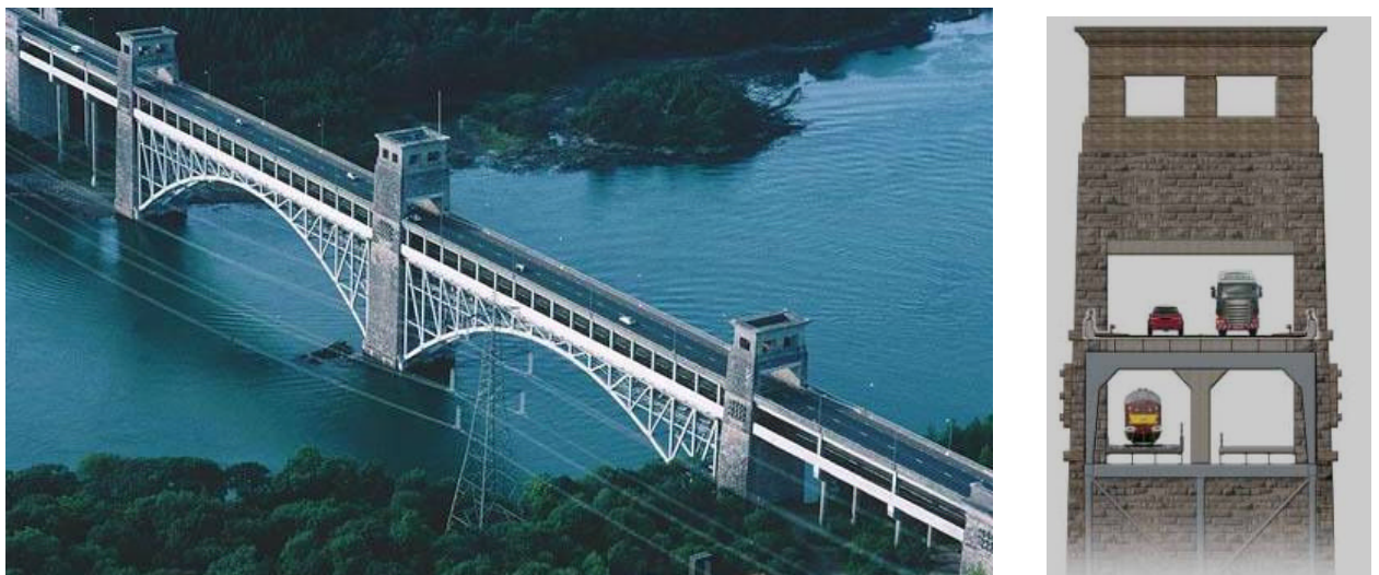
Figure 67 : Le « Britannia bridge » rénové (1970-1972)
