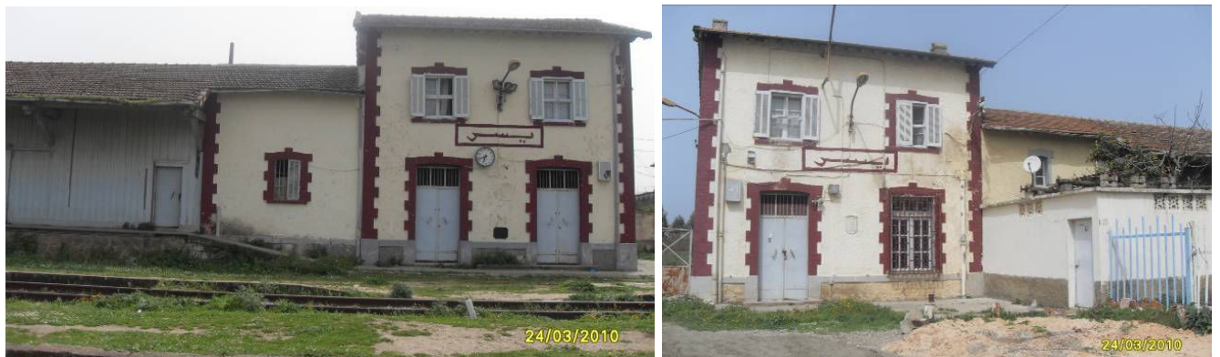
Figure 154 : Gare des Isser, état relativement bon du bâtiment voyageur. Les façades côté rails (à gauche) et côté cours (à droite) [Source : Photo personnelle]
