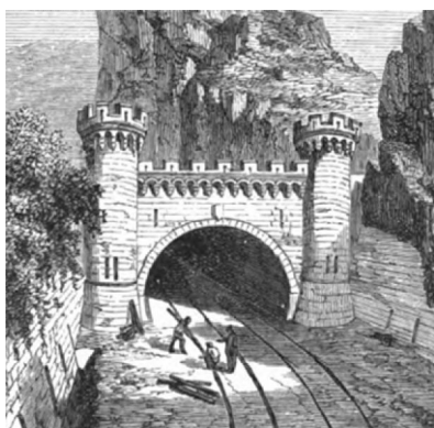
Figure 95 : Entrée d'un tunnel frontalier. Les tours, percées de meurtrières avec ces machicoulis, donnent l'aspect d'un fort pittoresque. [A. Guillemin, op. cit., p. 82]
