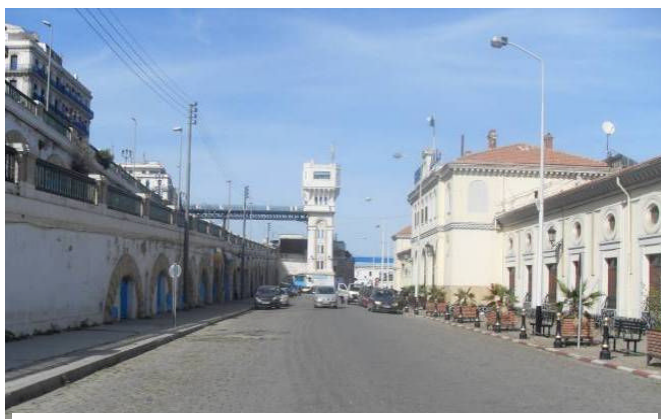
Figure 106 : Avenue de la gare et l'ascenseur (au fond) au niveau du bastion centrale (n° 18) [Source : Photo personnelle]
