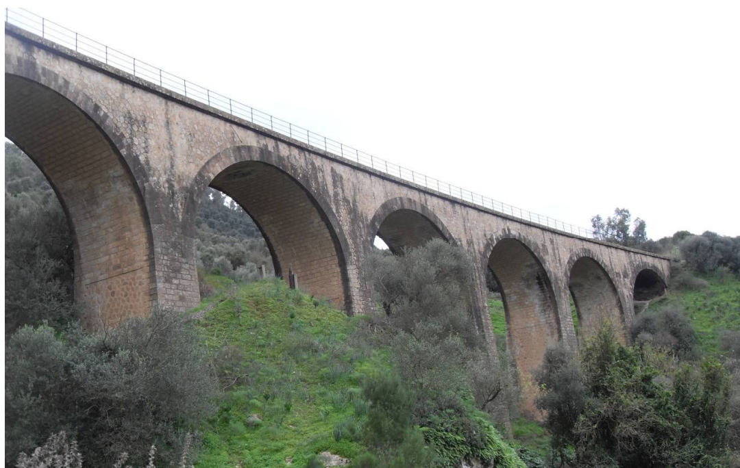
Figure 171 : Viaduc ferroviaire sur oued chender à Naciria, vue partielle. Ouvrage à 8 arches, en plein cintre, de 12m d'ouverture chacune.
