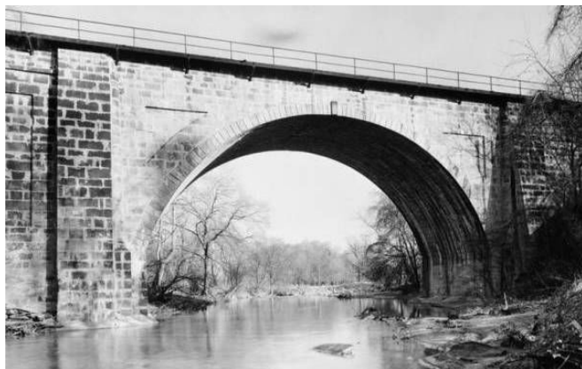
Figure 68: Le Carrollton Viaduct (1829) [Source : http://fr.structurae.de/photos ]
