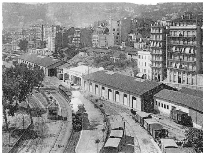
Figure 99 : La gare Agha vers 1920, où l'on aperçoit, au milieu, l'immeuble servant de bâtiment des voyageurs, actuellement démoli. [Source : P. Bejui et al, op. cit., p.14]
