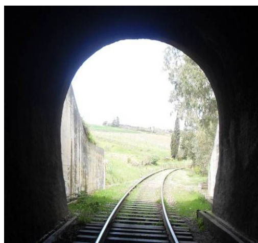
Figure 195 : Le tunnel de Naciria.
