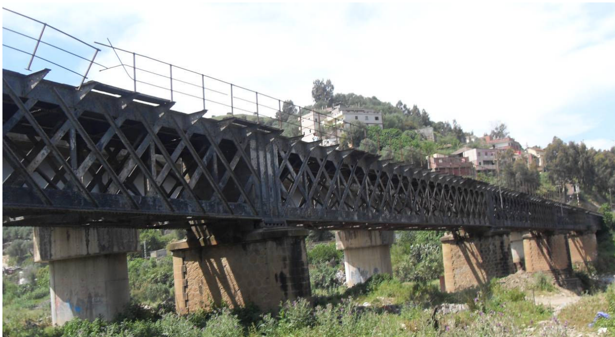
Figure 182 : Le pont métallique sur l'oued Bougdoura à Draa Ben Khedda, vue partielle. [Source : Photo personnelle]
