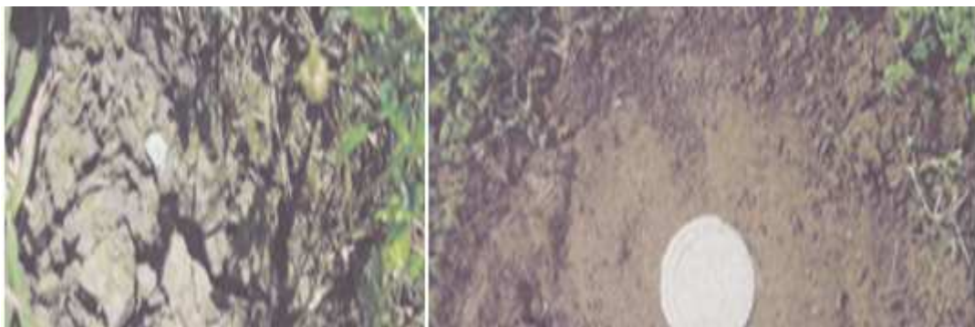
Fig.1.11 : Etat avant et après préparation de la surface de sol
