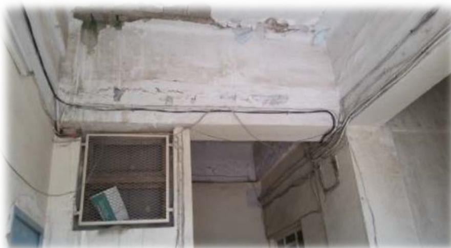
**Figure 29:**Infiltration des eaux pluviale au niveau du plancher
