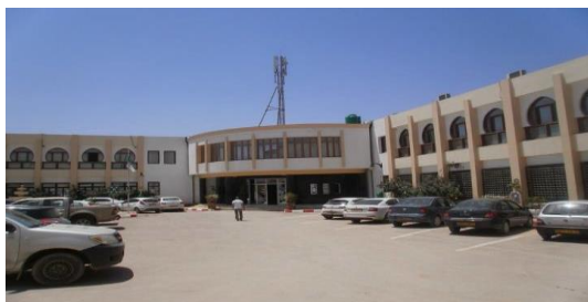
Bâtiment administratif ADWAN Chemicals
