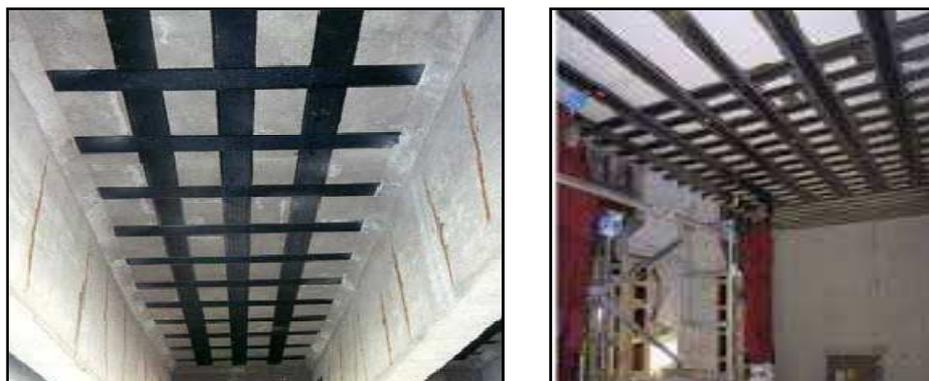
*Figure I.12.* Renforcement des dalles en béton par des bandes en CFRP [29]
