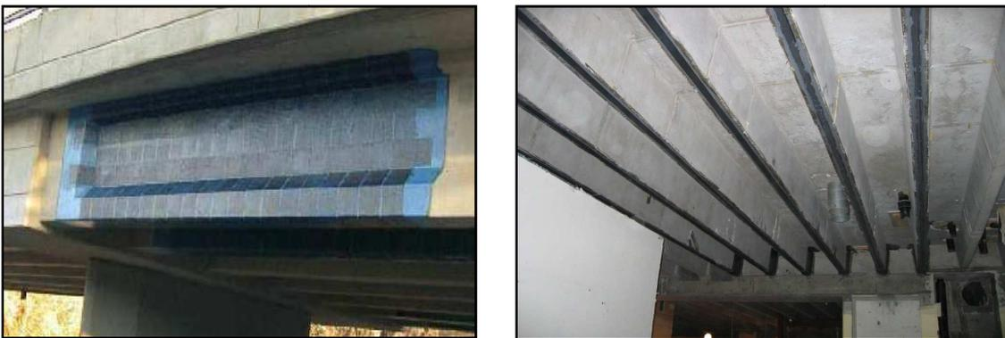
*Figure I.15.* Renforcement des poutres et culées de pont [31, 32]
