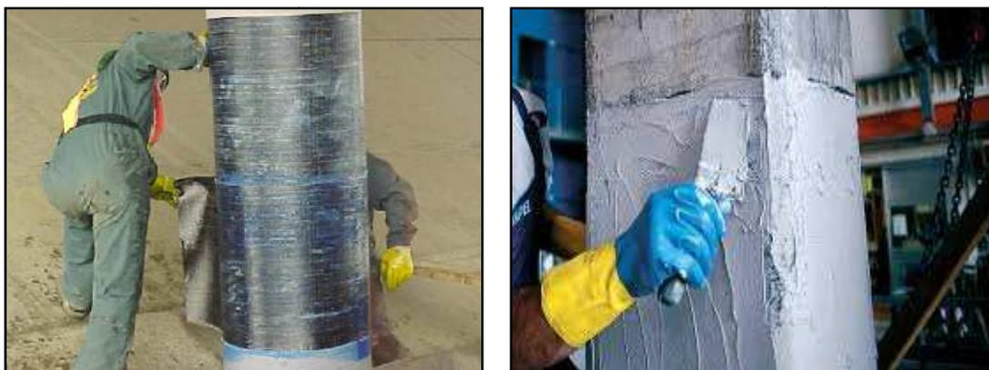
**Figure I.13.** Confinement des colonnes (cylindrique et carré) par des composites [30]
