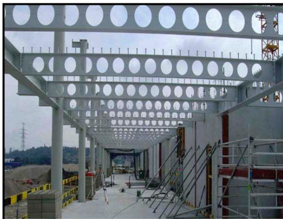
Figure 208 : Poutre alvéolaire.
