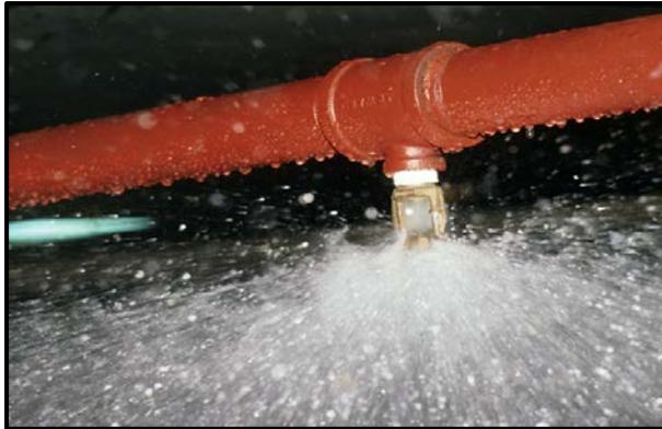
Figure 228: La conduite des sprinklers.
