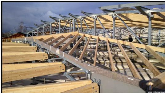
Figure 120 : Le bois et les treillis métalliques.
