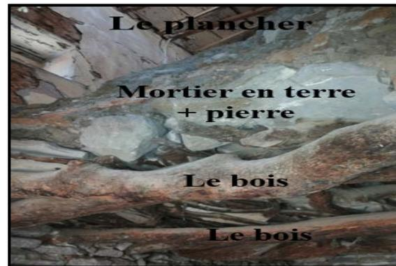
Figure96 : Système constructif des planches.
