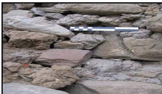
Figure102 : Mortier d'hourdage en terre.
