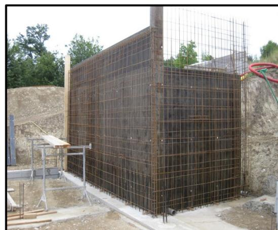
Figure 199 : Ferrailage mur de soutènement.
