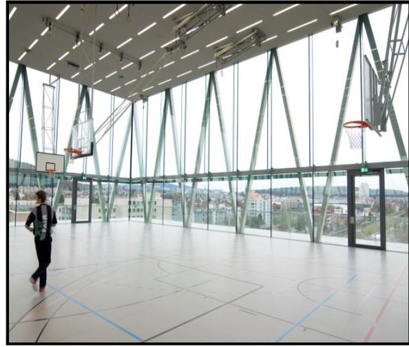
Figure 202 : Vue d'intérieur, une fluidité et une transparence offerte par les poutres cloisons.
