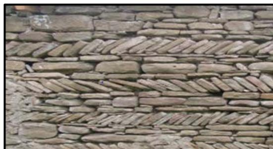
Figure101 : Appareillage spécial en épi.
