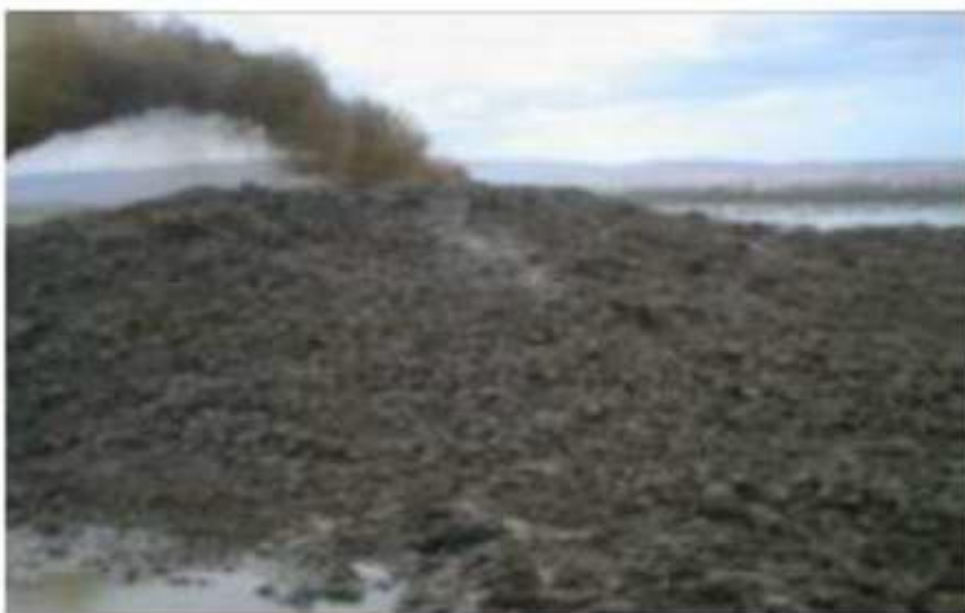
Figure II.4 : Rejet de la vase draguée (Barrage de Fergoug ).
