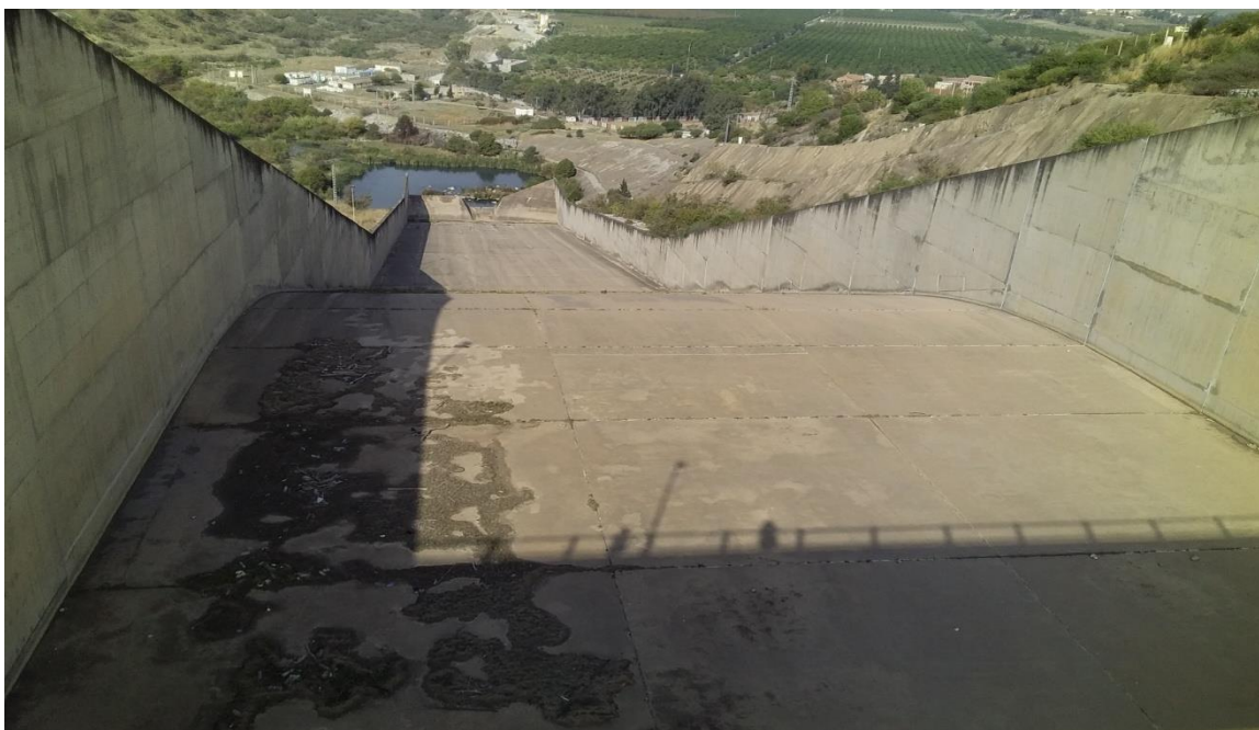
Figure III.2 : Déversoir latéral à seuil libre.
