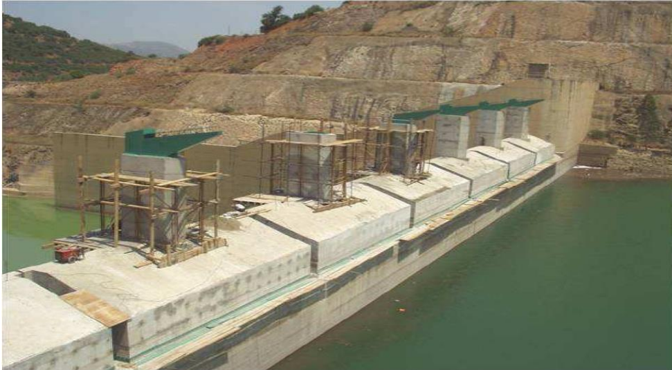
Figure. II.2 : Surélévation à l'aide de hausses fusibles du barrage de Beni-Amrane (Boumerdes).
