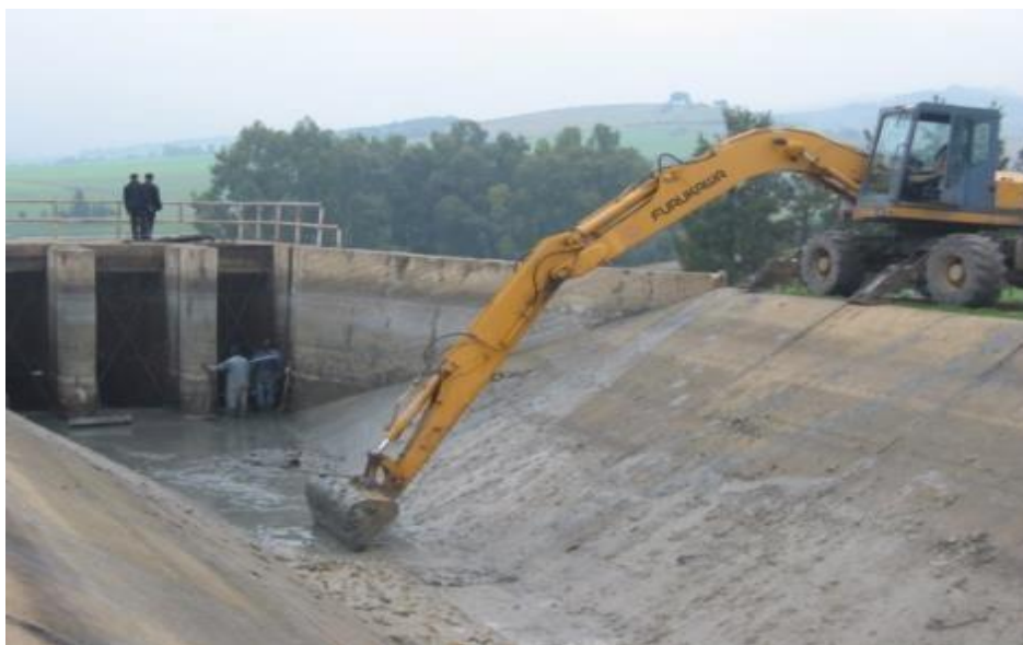
Figure I.10 : Curage d'un canal par les moyens mécaniques.
