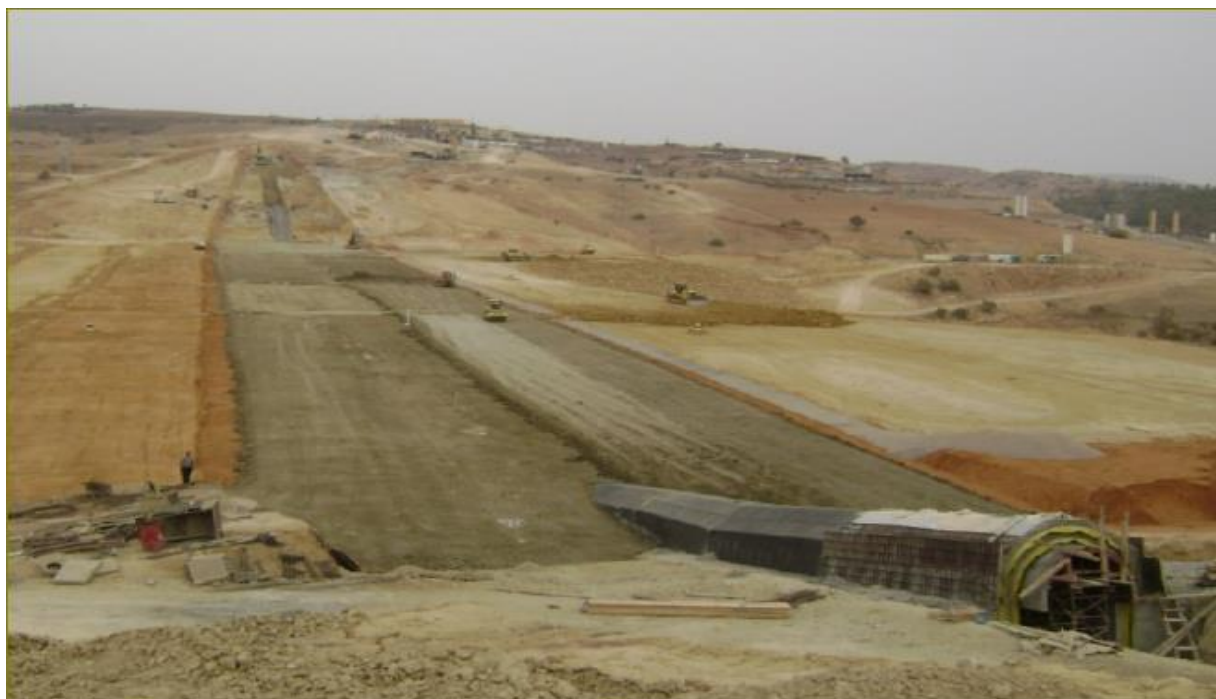
Figure V.5: Couche de remblai de vase de dragage.
