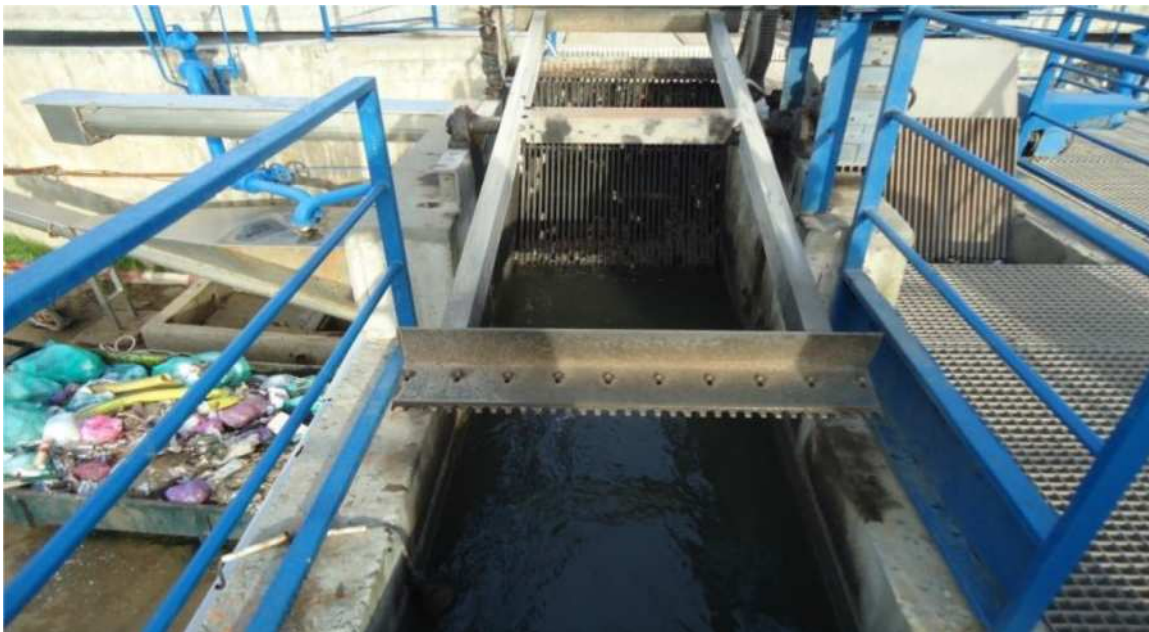
Figure I.2.3. Dégrilleur.
