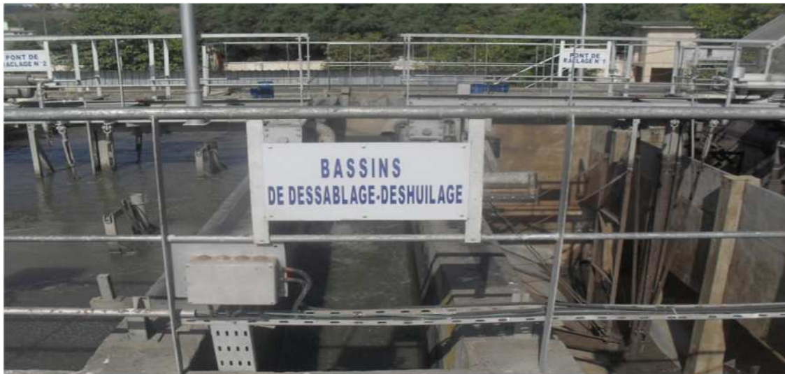
Figure I.2.4.Déssableur-Dégraisseur
