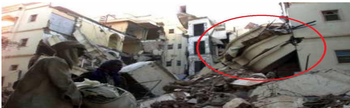
Figure I.19: Effondrement des balcons en porte-à-faux, séisme Gujarat, en Inde (2001).
