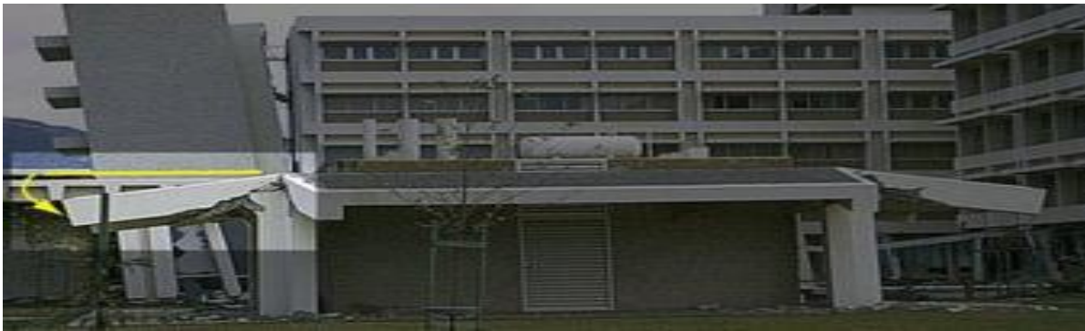
Figure I. 21 : Une rotation de la poutre console, séisme de San Fernando, en Californie(1971).
