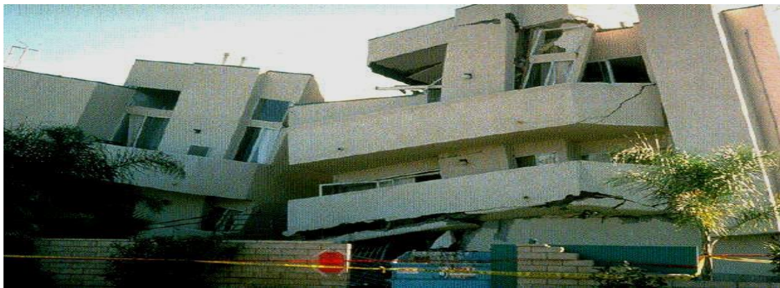
Figure I.18 : Effondrement des porte-à-faux, séisme Los Angeles (1994).
