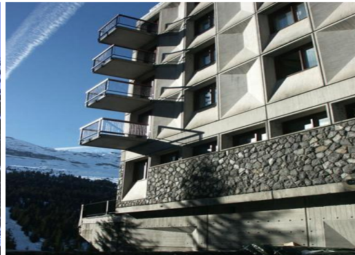
Figure I.12 : Des balcons "plongeoir" une falaise de l'hôtel Le Flaine.
