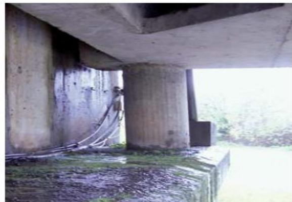
**Fig. XI.2 :** Les appareils d'appuis en béton.
