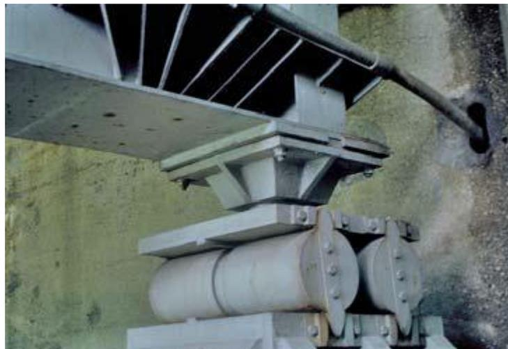
**Fig. XI.4 :** Les appareils d'appuis en acier.
