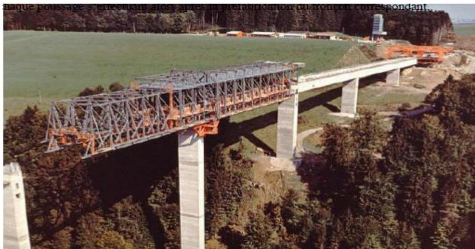
**Fig. I.19 :** *Construction par poussage.*
