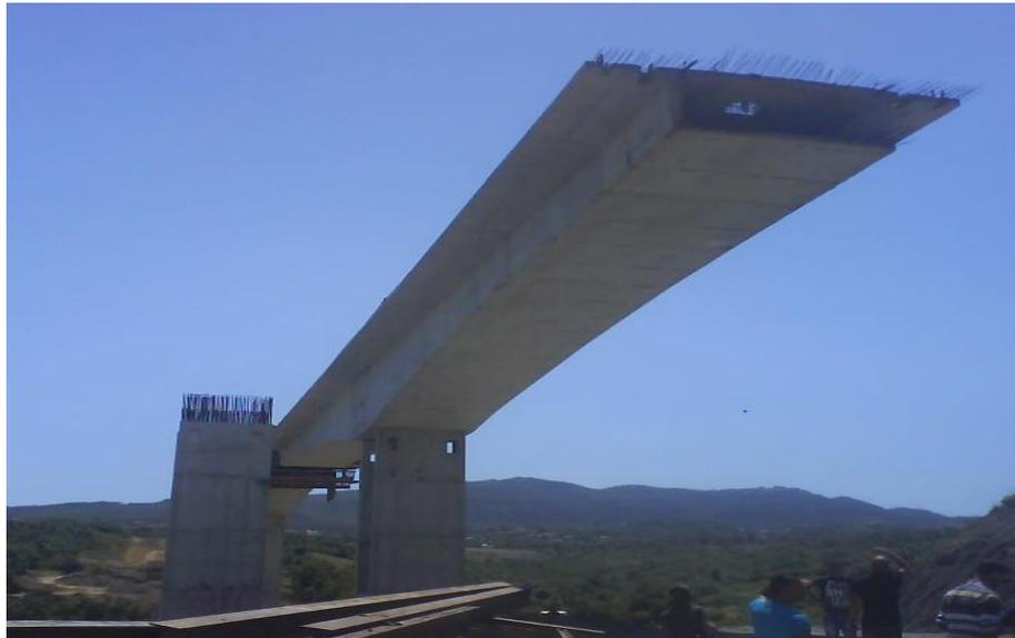
**Fig. I.13 :** *Tablier du viaduc d'Azazga a poutre-caissons.*
