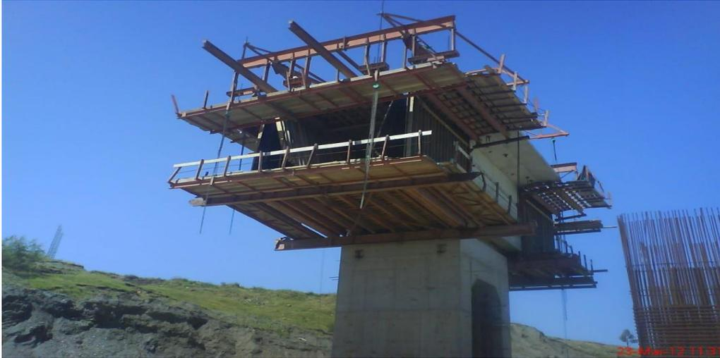
**Fig. 1.6 :** *La disposition de l'équipage.*
