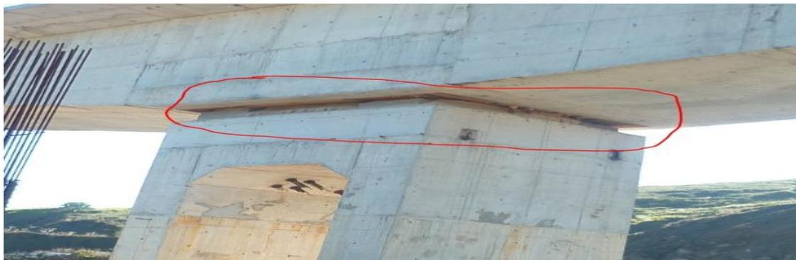
**Fig. XI.9 :** appareil d'appui en élastomères frettés
