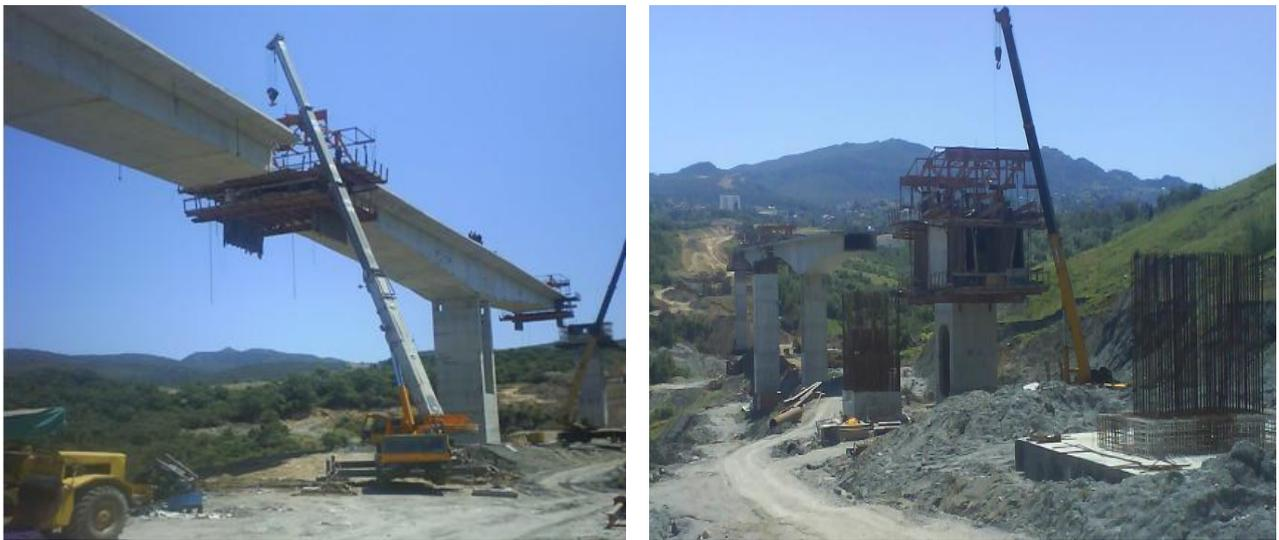
**Fig. I.21 :** *Construction par encorbellement du tablier du viaduc d'Azazga.*
