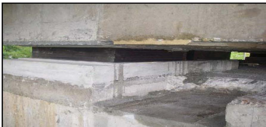
**Fig (IX.5): Appareil d'appui en élastomère fretté.**
