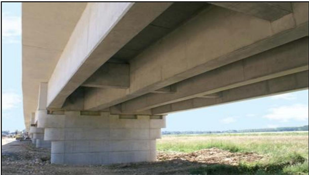
**Fig (I.10): Pont à poutres multiples en béton précontraint par post-tension.**
