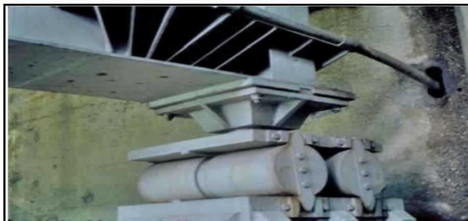
Fig (IX.4): Appareil d'appui en acier.
