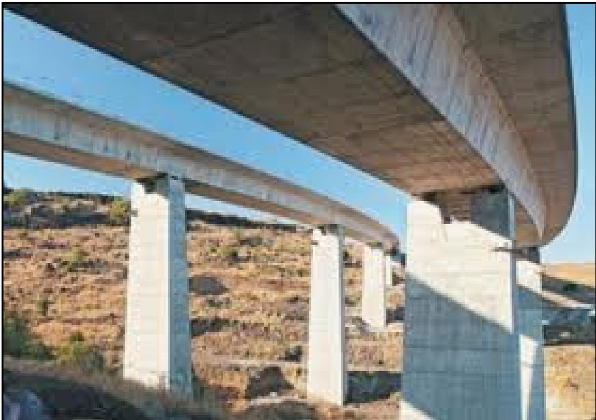
**Fig (I.12): Pont en béton précontraint construit en encorbellement successif.**
