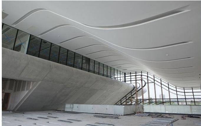
Figure 16: Un faux plafond en plâtre en forme ondulée.
