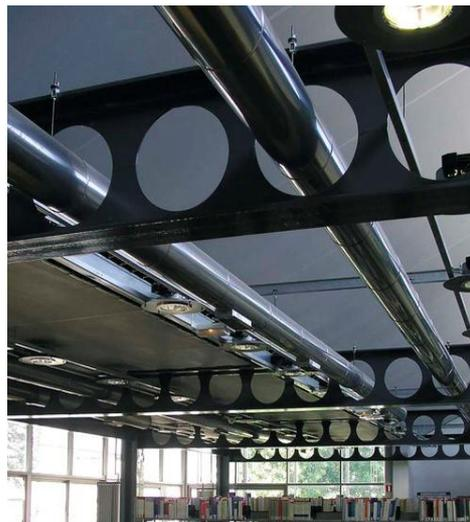
Figure 10: Les poutres alvéolaires.
