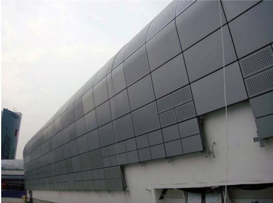
**Figure 29: Façade avec des panneaux en aluminium à double courbe.**
