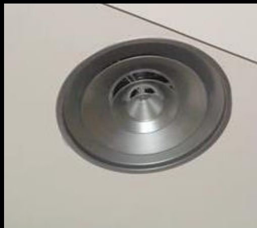
Fig101: photo montrant une bouche de soufflage SS:www.arcelormittal.com
