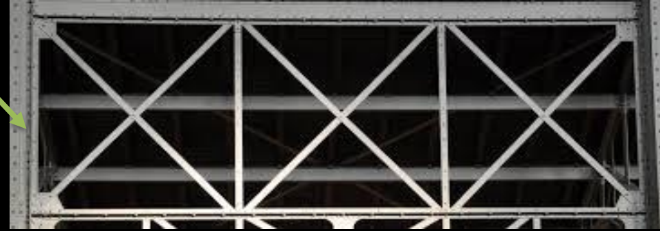
Fig9: schéma montrant les contreventements
