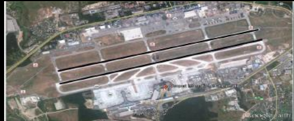
Fig39: photo d'un aéroport à deux piste parallèles SS: Image satellite (Google earth)
