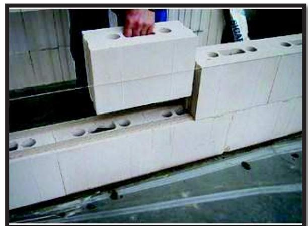
Fig144: photos des briques silicio-calcaire
