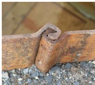
Figure II.5. Serrure à la jonction de deux palplanches
