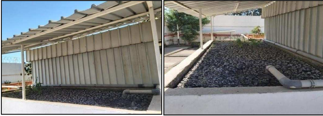
Figure 03 : Lit de séchage
