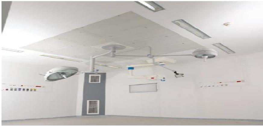
**Figure V.5 :** Exemple de salle d'opération, équipée de plafond filtrant et de grille de reprise.[4]
