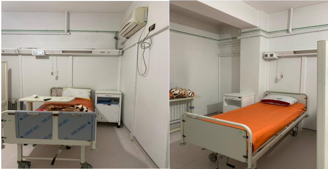
Figure III.9 : les chambres plombées.
