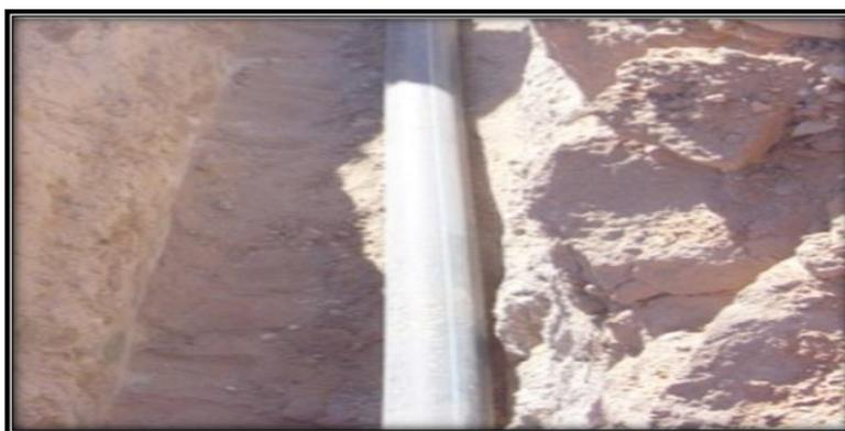
**Figure 5.1 : Pose des conduites en terre.**
