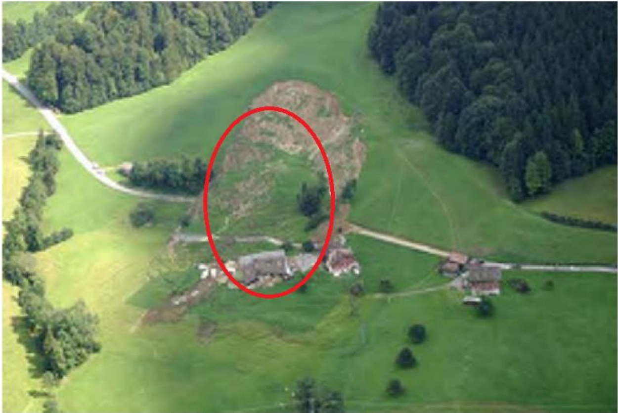
FigureII-12: illustration du glissement de terrain affectant le versant du Holberg(source: Google- glissement Suisse).
