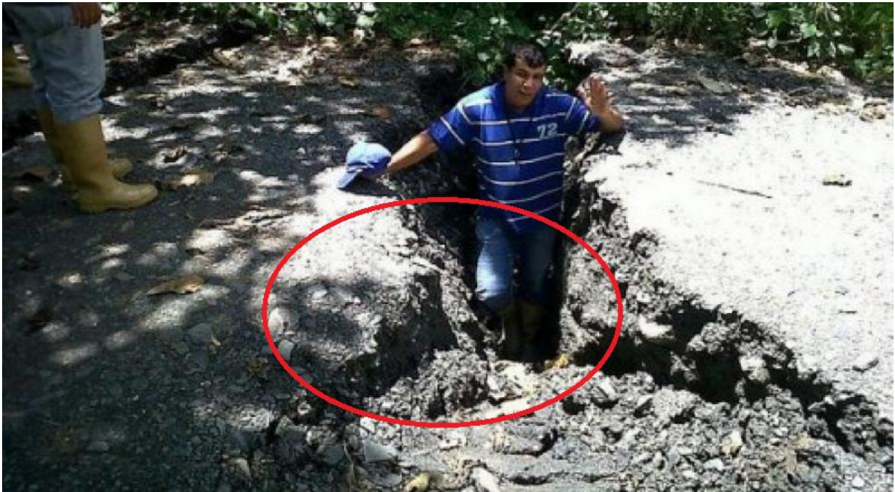
Figure II-8: fissuration et affaissement causé par le glissement de terrain en Colombie(source: état du monde)
