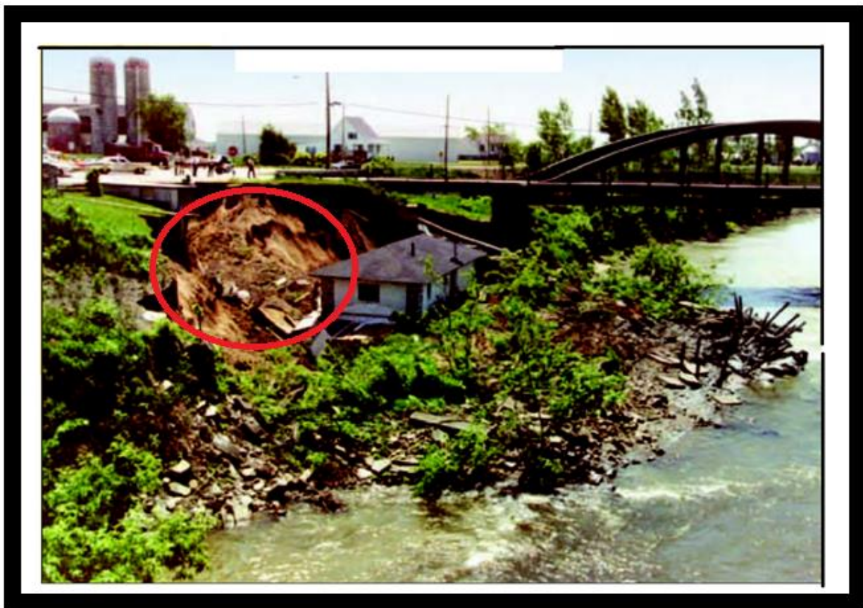
Figure II-4: dégâts engendrés par un glissement au Canada. (source: Etat du monde)
