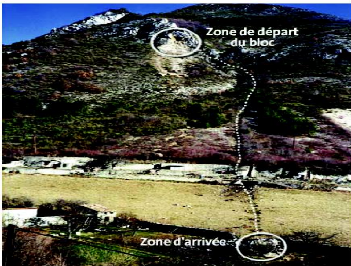
Figure I-17: Chute d'un gros bloc à Veynes (Hautes-Alpes,05) –1996.
