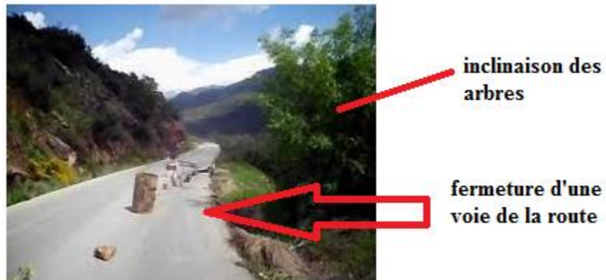
Figure II-19: fermeture d'une voie de la route.
