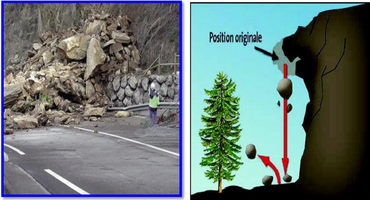
Figure I-16: phénomène d'écroulement(source: BRGM).
