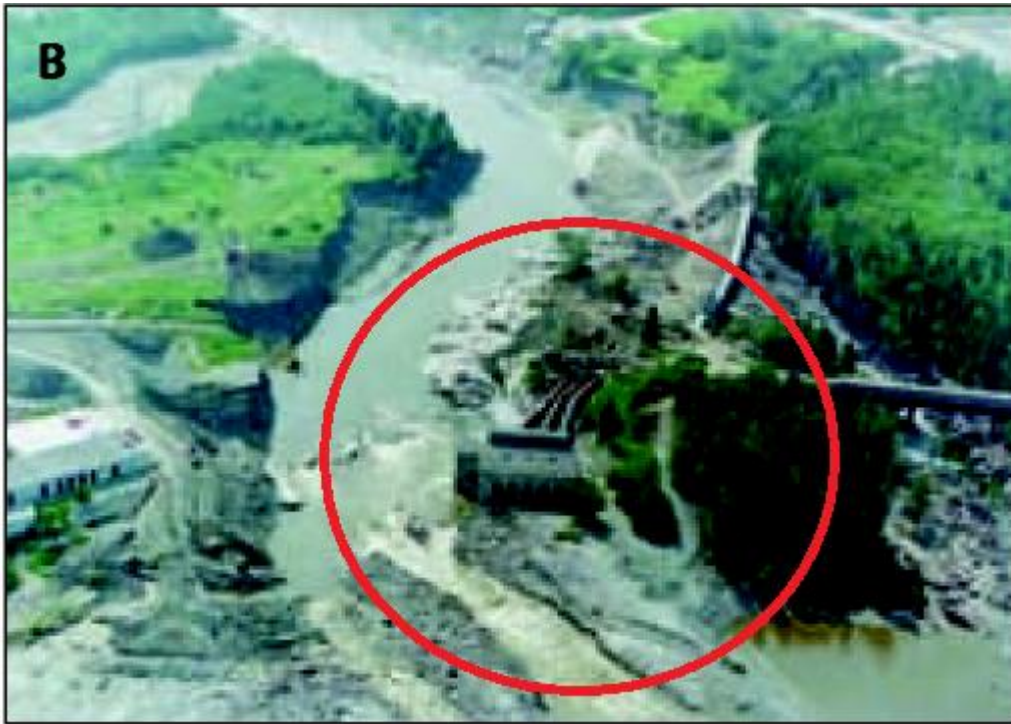
Figure II-6: vue aérienne du site précédent après changement du lit d'un cours d'eau (source: Hydro-Québec photographies aériennes)
