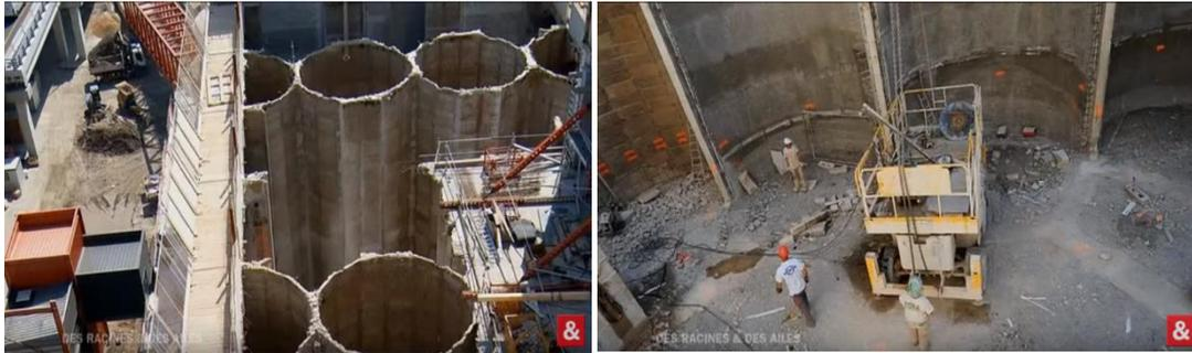
Figure II-74 : opération d'évidement du silo de Marseille
