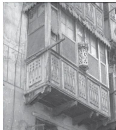
**Figure II.17 :** dispositif de captage, répartition protection et contrôle de lumière.
