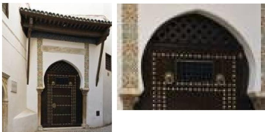
**Figure IV. 11:** Grille d'aération du montant fixe de la porte d'entrée.
