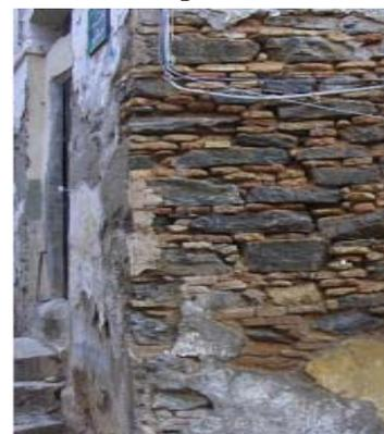
**Figure III. 22:** Mur mixte avec brique cuite et pierre angulaire. (Source : PPSMVSS)
