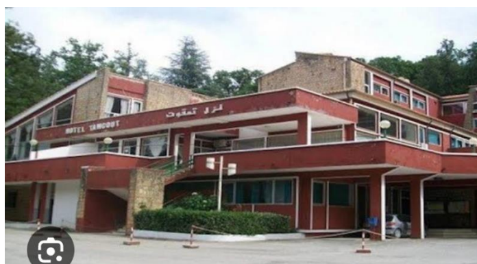
Figure 46 : Hôtel Tamgout avant travaux de réhabilitation.
