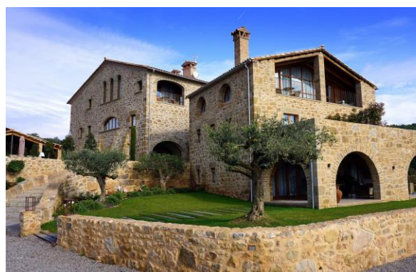
Figure 15 : construction en pierre locales. Source : https://corebat.pro/
