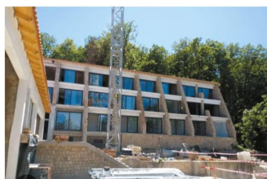
Figure 45 : Hôtel Tamgout en travaux de réhabilitation.
