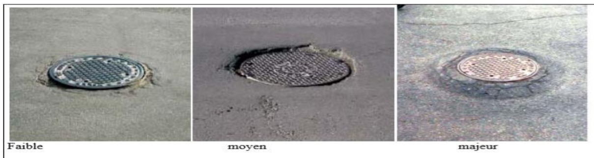
Figure 20 : Dénivellation des regards [4]
