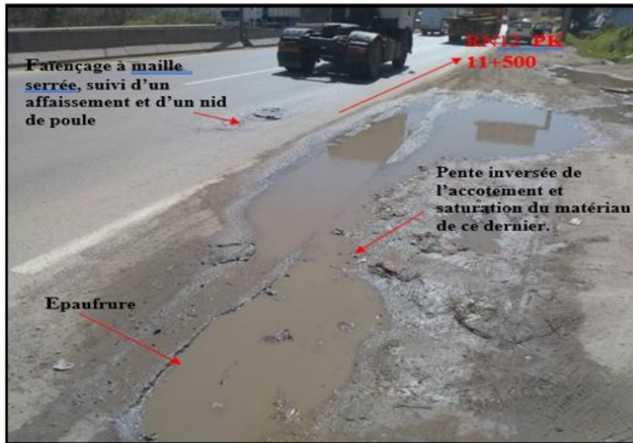
Figure 32 : Représente un affaissement de la RN12 [11]
