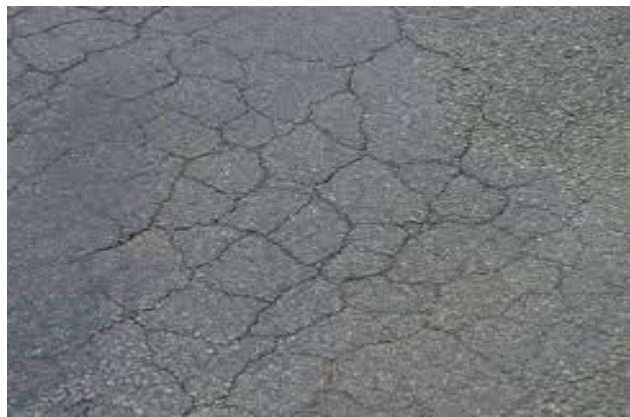
Figure 31 : Représente le faïençage de la RN12 [12]
