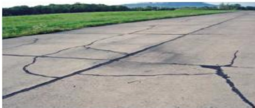
Figure 23 : pompage dans les chaussées rigides [5]
