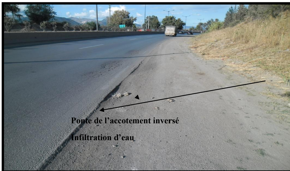
Figure 33 : Pente de l'accotement inversé [11]
