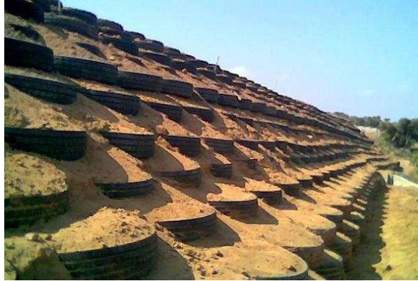
Figure I.21. Chantier expérimental Pneusol à Bou-Smail
