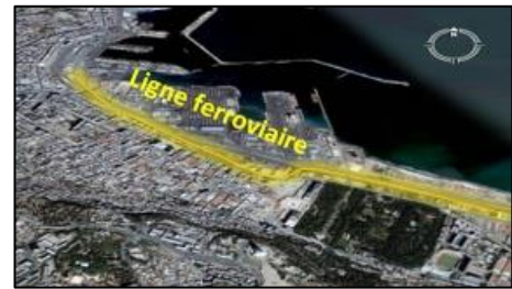
Figure 60 : ligne ferroviaire Hamma Source : Google Earth traité par l'auteur
