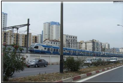
Figure 61: ligne ferroviaire Hamma Source : Google Earth traité par l'auteur
