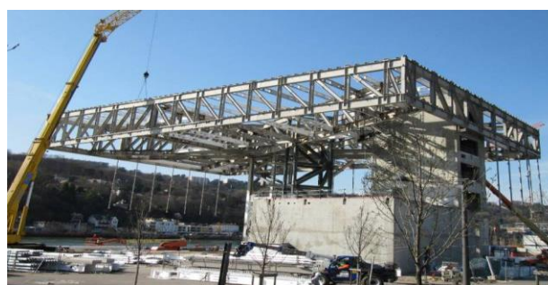
Figure201 : image en cours de construction de l'ossature métallique source : https://www.google.com
