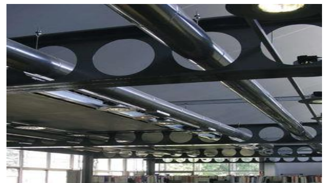
Figure184 : poutres alvéolaire Source : http://amandinelohay.wixsite.com/monsite/integrati on-techniques
