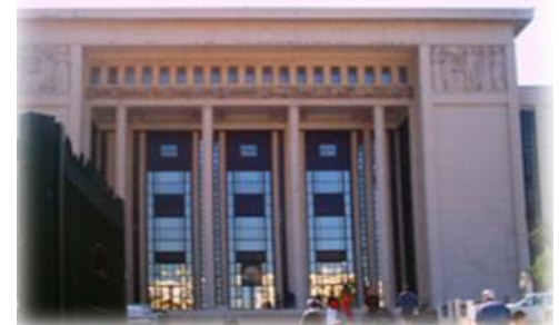
Figure 71: place UGTA Source :auteur
