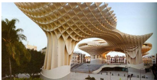
Figure 90 : Belvédère en bois, Séville (Espagne) Source : http://nuitdepleinelune.fr
