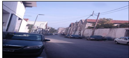
Figure 57 : Façade sur Med Bouharfa Source : auteur
