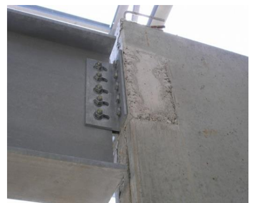
Figure186: détail assemblage poteau poutre Source : http://detailsconstructifs.cype.fr/EAM014.html
