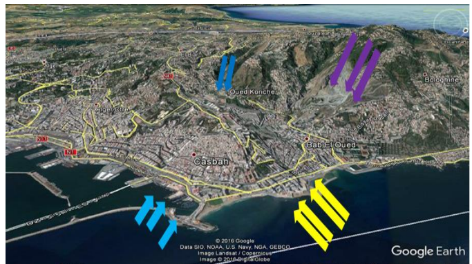
Figure7 : vue aérienne d'Alger Source : Google map
