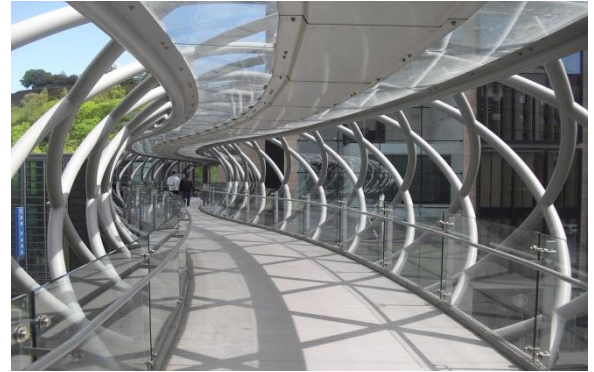
Figure202 : passerelle piétonne en acier Source : www.google.com
