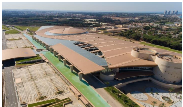
Figure 119 : le centre internationale de conférences.d'Alger Source : http://www.fabrispartners.it
