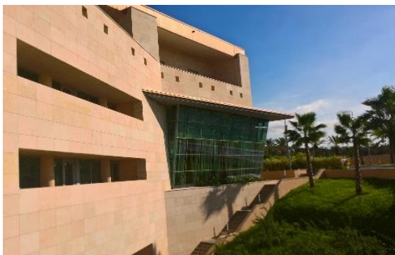
Figure 125 : parois inclinés restaurant (C.I.C) Source : auteur
