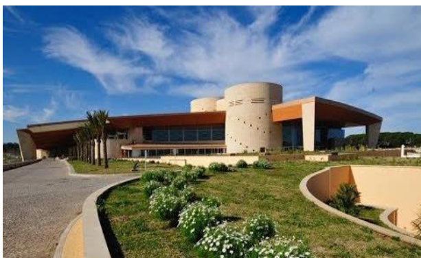
Figure 118 : le centre internationale de conférences.d'Alger Source : http://www.fabrispartners.it
