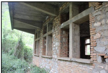
Fig 152 : Façade du bloc I laissée à l'état brut sans traitement. Source : Auteurs
