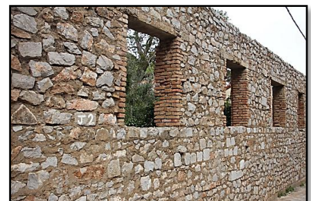
Fig 146 : Murs en pierre de l'édifice. Source : Auteurs
