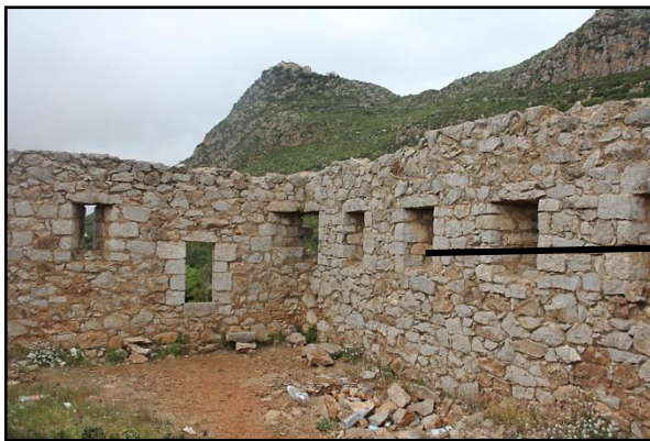
Fig 157 : Ouvertures du poste de surveillance. Source : Auteurs
