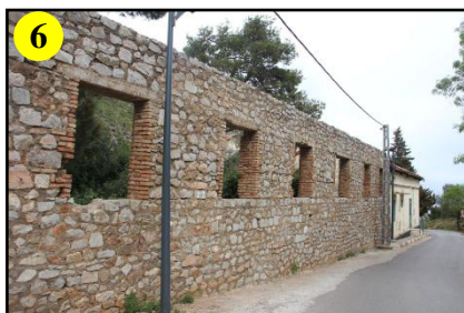
Fig 160 : Murs extérieurs du bloc B. Source : Auteurs
