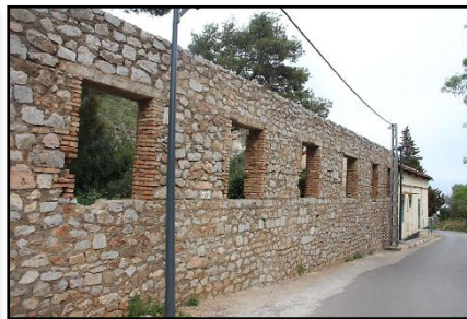
Fig 153 : Muraille en pierre. Source : Auteurs
