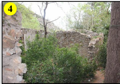
Fig 162 : Murs intérieurs des cellules. Source : Auteurs
