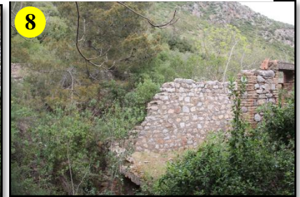
Fig 166 : Murs extérieurs du bloc F. Source : Auteurs
