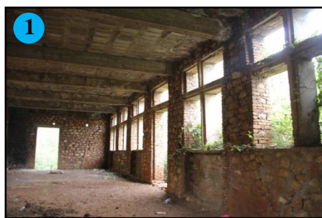
Fig 175 : Espace intérieur du bloc I. Source : Auteurs
