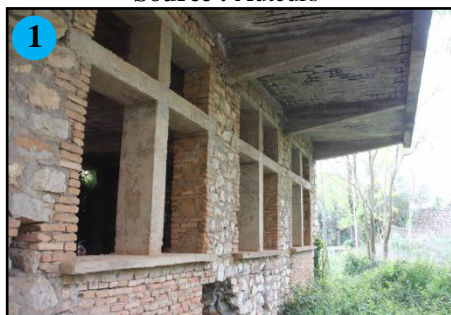
Fig 174 : Mur extérieur du bloc I. Source : Auteurs
