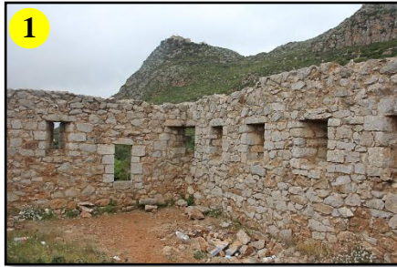
Fig 166 : Ouvertures du blocus. Source : Auteurs
