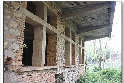
Fig 151 : Murs porteurs et plancher en béton armé du bloc J. Source : Auteurs
