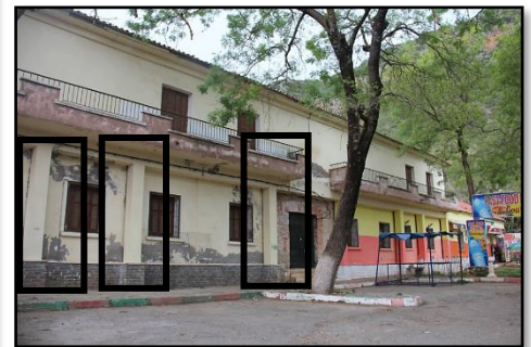
Fig 151 : Poteaux extérieurs soutenant le bloc J. Source : Auteurs
