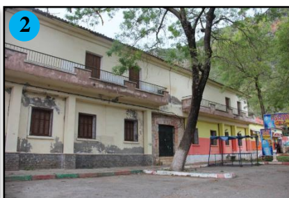
Fig 172 : Murs extérieurs du bloc J. Source : Auteurs
