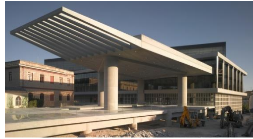
Fig. 3. 50. Seuil d'entrée de musée Source. Archidayli
