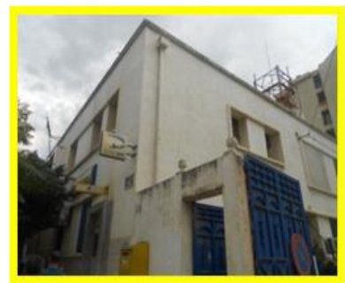
Fig 2.52. La poste Source : Auteurs
