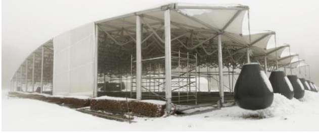
Fig 1.24. Croquis de la couverture de fouille de Bibracte Source : www.tess.fr
