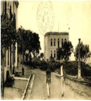
Fig 2.12. Hôtel de ville Source : Site Web – Les Tizis-
