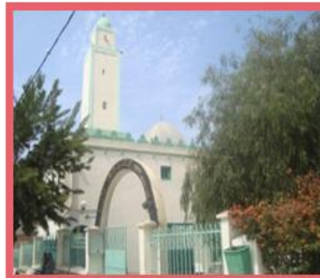
Fig 2.54. La mosquée Source : auteurs
