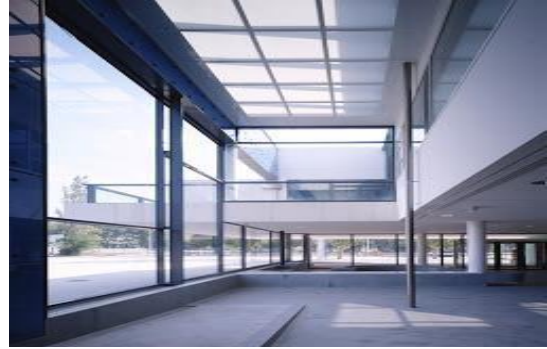
Fig. 3. 31. volume vitré formant plafond d'un espace de grande hauteur Source : http://ciriani-en-arles.blogspot.com
