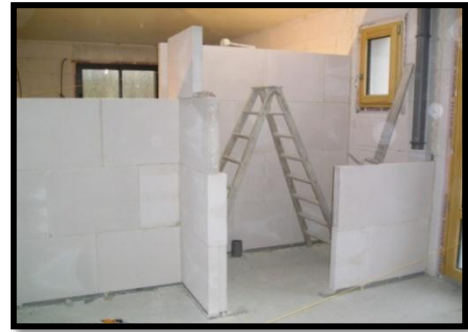
Figure 144 : cloisons en siporex http://www.storage.canalblog.com
