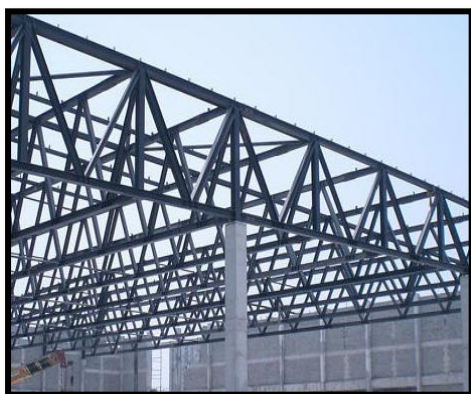
Figure125: photo d'un assemblage poteau béton armé /poutre métallique
