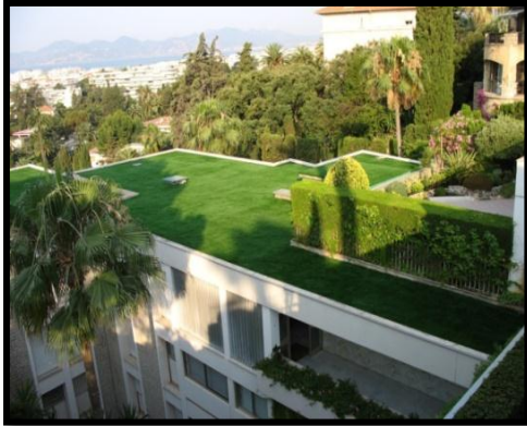
Figure 118 Photo d'un toit jardin http://www.universgazons.com
