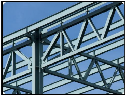
Figure123: photo d'un assemblage poteau/poutre métallique
