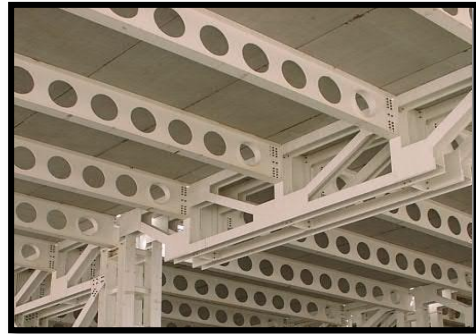
Figure116: photo d'une poutre alvéolaire.
