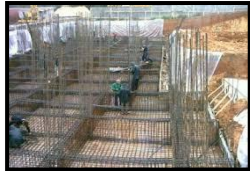
Figure110: photo d'un radier nervuré.
