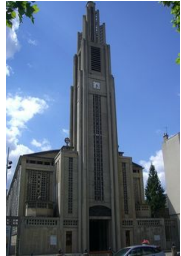
Figure 52: Église Notre-Dame de la consolation, Auguste Perret, Le Raincy (93), 1922-1923. Source: Photo de THIAGO LORENTE, consulté le 25 septembre 2016, in URL: https://www.pinterest.com/pin/317926054923095870/
