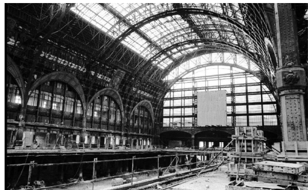
Figure 22: aperçu sur la structure métallique de la gare d'Orsay, Victor Laloux Architecte; 1900. Source: Consulté le 20 Septembre 2016; in URL: http://pietondeparis.canalblog.com/archives/2009/08/25/14843610.html
