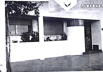
Façade de l'immeuble et entrée principale
