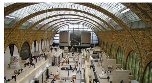
Figure 23: aperçu sur l'intérieur de la gare d'Orsay (Actuel Musée d'Orsay), où la structure métallique est enveloppée de maçonnerie et d'un revêtement. Source: Consulté le 20 Septembre 2016, in URL: http://paris1900.lartnouveau.com/paris07/musee_d_orsay.htm
