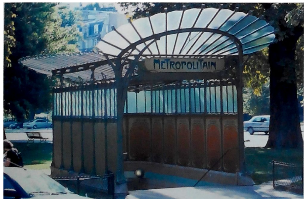
Figure 27: Entrée du métro, Paris, XVIe Arr, station porte Dauphine, 1900-1902, Hector Guimard architecte. Source: Monnier Gérard, 2004, L'Architecture du XXe siècle, un patrimoine . Edt Scéren, Paris, p. 25
