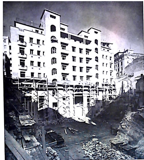
Figure 59: Groupe d'immeubles en structure métallique, Léon Preuilh, Alger (Rue Michelet et rue du Languedoc), 1932. Source: J.L, «Deux groupes d'immeubles à Alger», in Revue Chantiers Nord-Africains , N 01, Janvier 1932, page 43.
