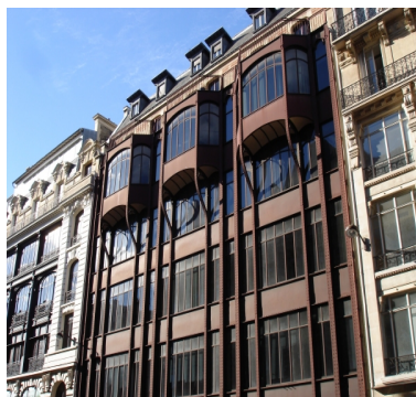
Figure 24: vue sur l'Immeubles rue Réaumur dont la structure est métallique, Paris 2e, N°124. Ancien immeuble du «Petit Parisien». Architecte: Chedanne, 1905. Source: Photo prise par Gérard Métron, Aout 2006, Consulté le 20 Septembre 2016 in URL: https://structurae.info/photos/68126-immeubles-rue-reaumur-paris-2en124-ancien-immeuble-du-petit-parisien-puis-du-parisien-libere-architecte-chedanne-1905
