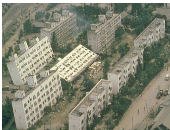
Figure II.17 : dommage du a l'élancement [16].
